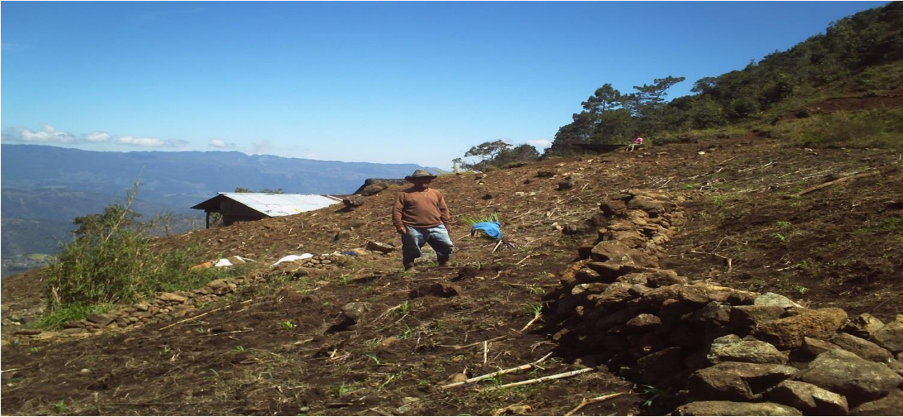
Figura 90: Estructura de barrera muerta
