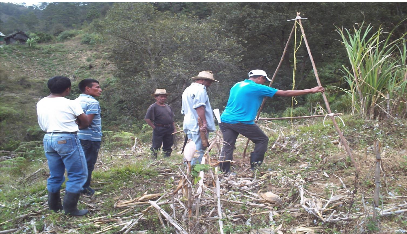
Figura 88. Trazado de las curvas a nivel en la comunidad de San Vicente.
