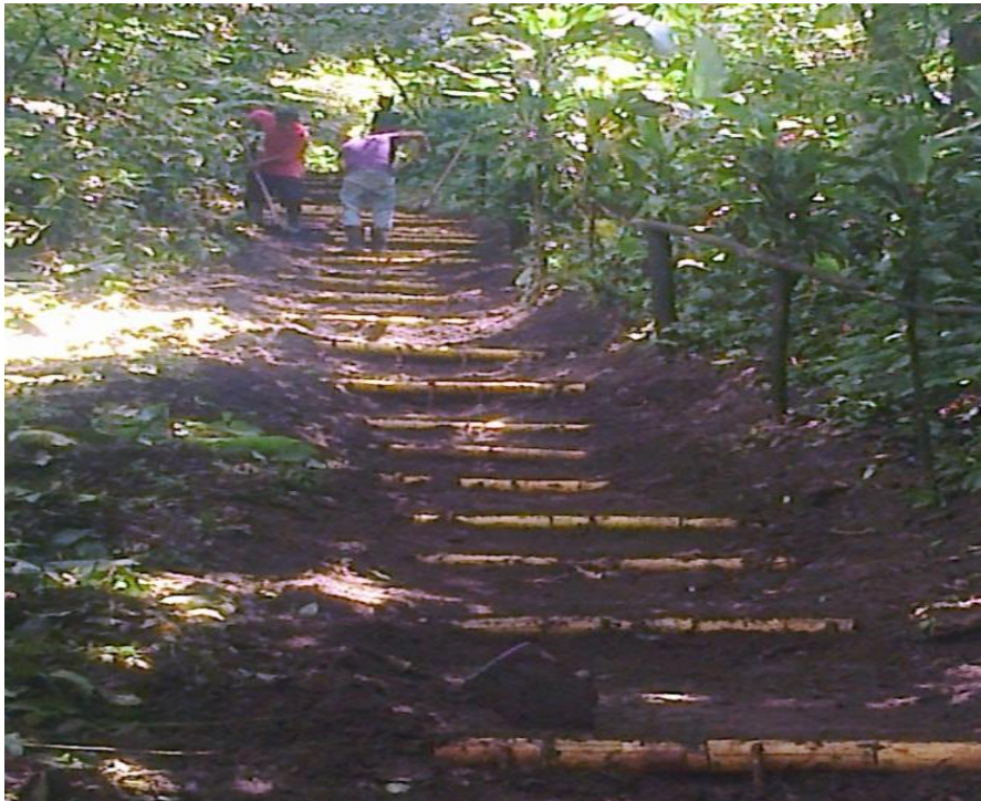
Figura 24 Estado de caminamientos después de las reparaciones.
