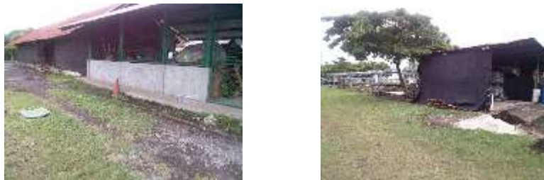
Figura 5. Bodega del departamento de biotecnología -BIOMag-
