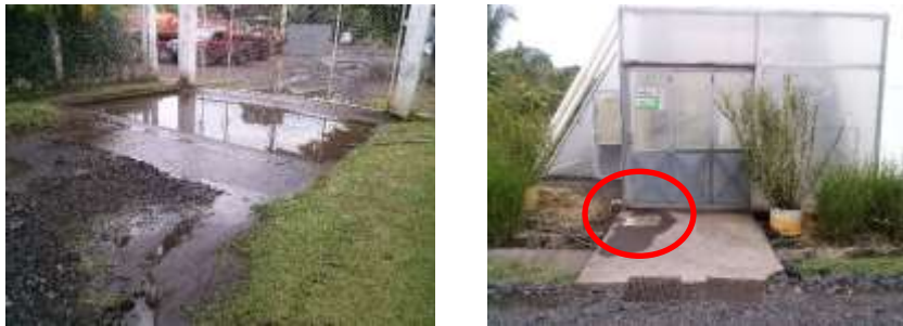
Figura 12. Estructuras físicas de bioseguridad, a. Rodiluvio, b. Pediluvio
