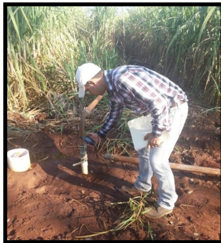
Figura 38. Ubicación geodésica de válvulas.
