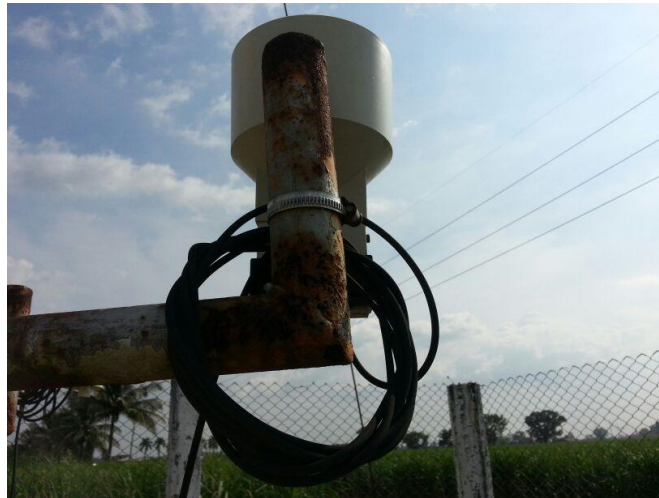
Figura 42 Cableado de pluviómetro en buen estado y debidamente ordenados.
