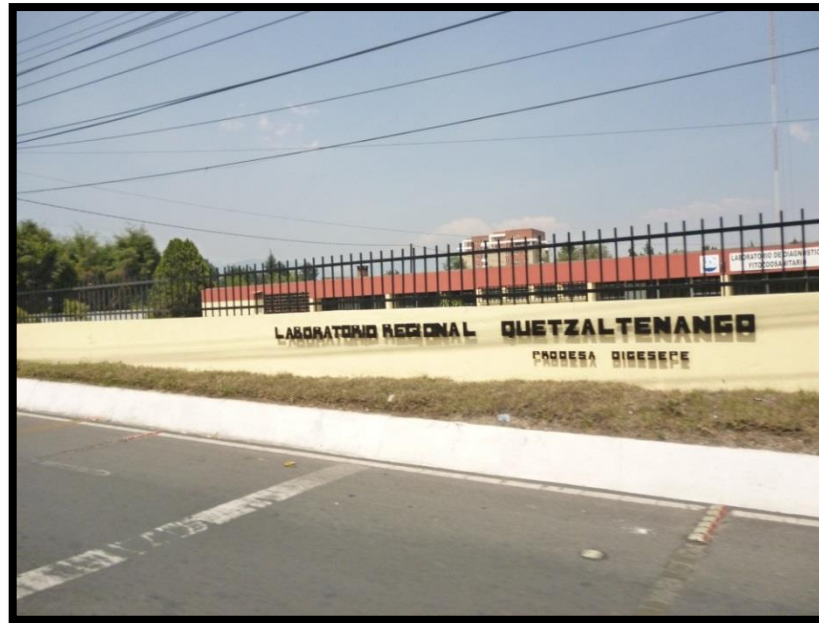
Figura 1A. Frente de las instalaciones del Laboratorio de Diagnóstico Fitosanitario de Quetzaltenango
