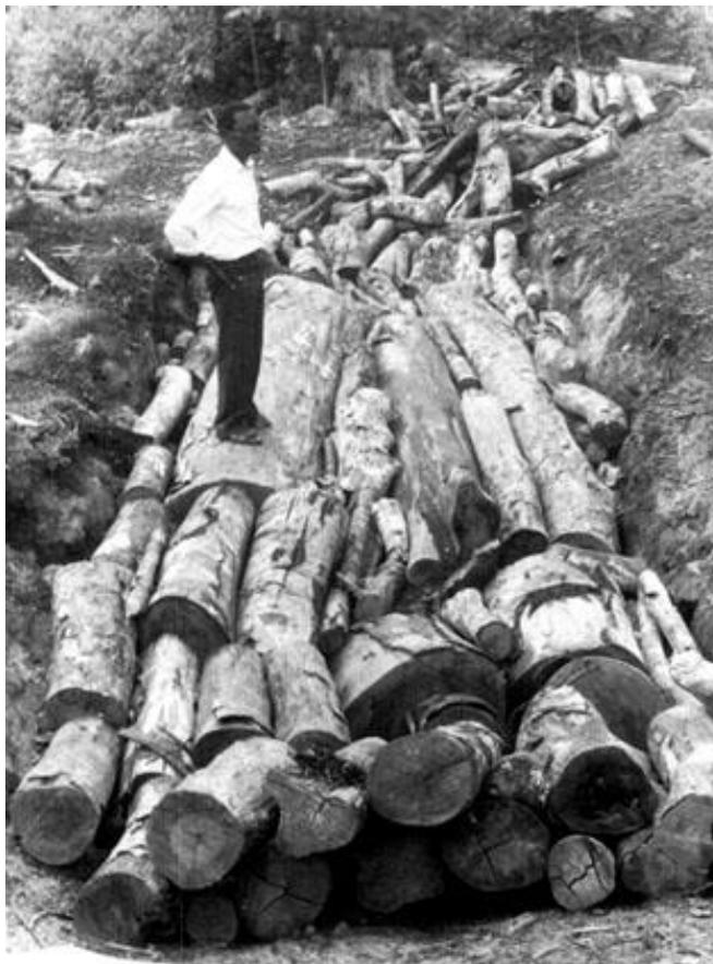
*Figura 2. Carbonera en fosa de tierra durante la etapa de carga. Observar el gran diámetro en rollo usado Ghana.
