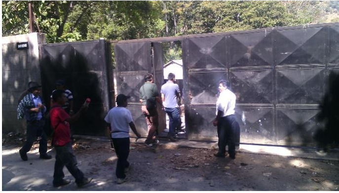
Figura 1 Ingreso Planta de Tratamiento
