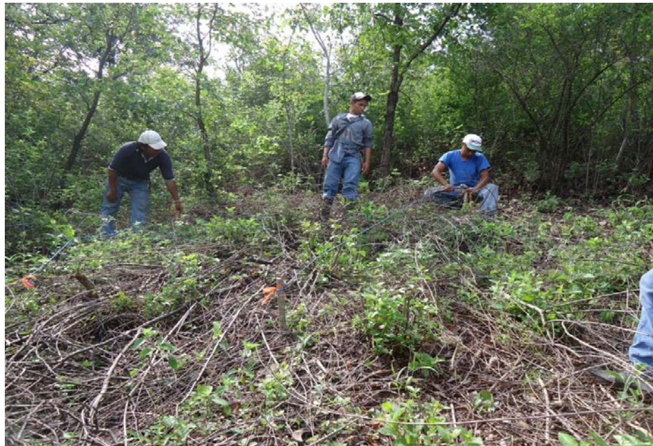
Figura 16A. Fotografía del marcaje del terreno. Fuente: elaboración propia, 2012.
