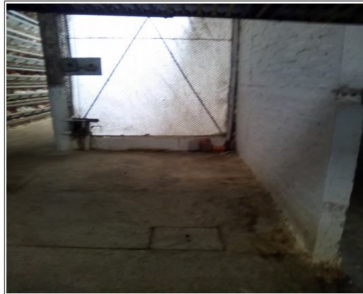
Figura 25. Parte frontal, entrada del edificio
