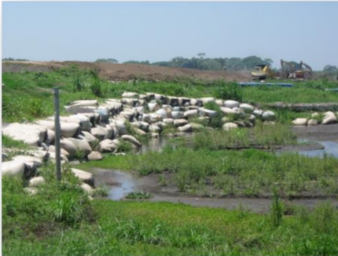
Foto 3. Bordas ejecutadas en Cerro Colorado, sobre el río Coyolate. Fuente: ICC.
