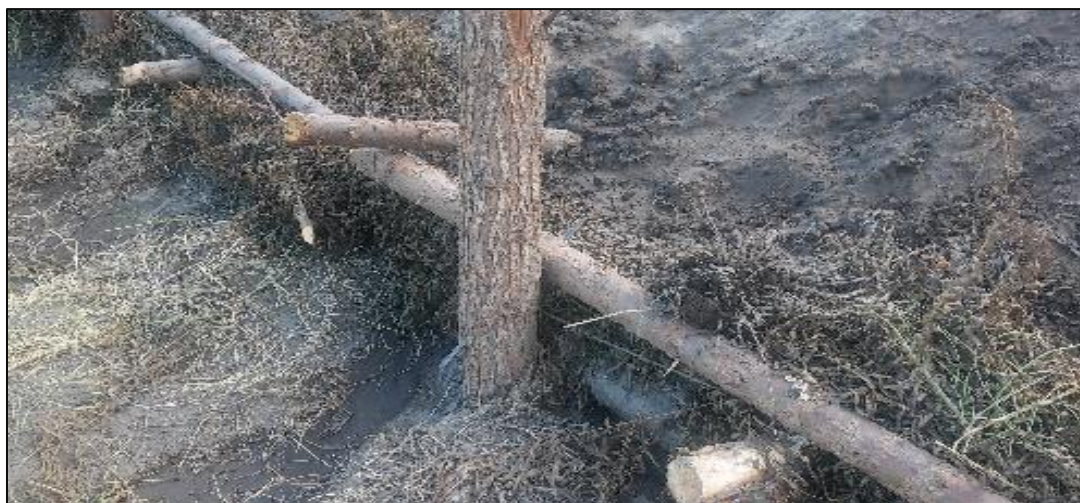
Figura 135 Anclaje de postes verticales, horizontales e inclinados (lanceros) en Finca El Manantial
