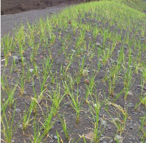
Fotografía 26 Introducción de vetiver en tramo 2 de Bocatoma
