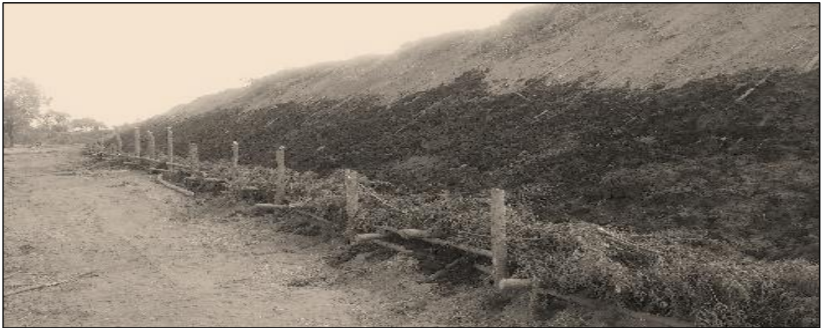
Fotografía 6 Enramado de sauce en talud frontal en Finca El Manantial
