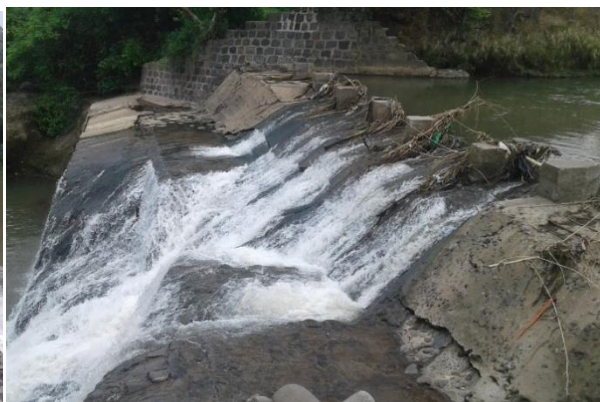
Figura 60A Represa en Parque Recreativo Ocosito, Retalhuleu
