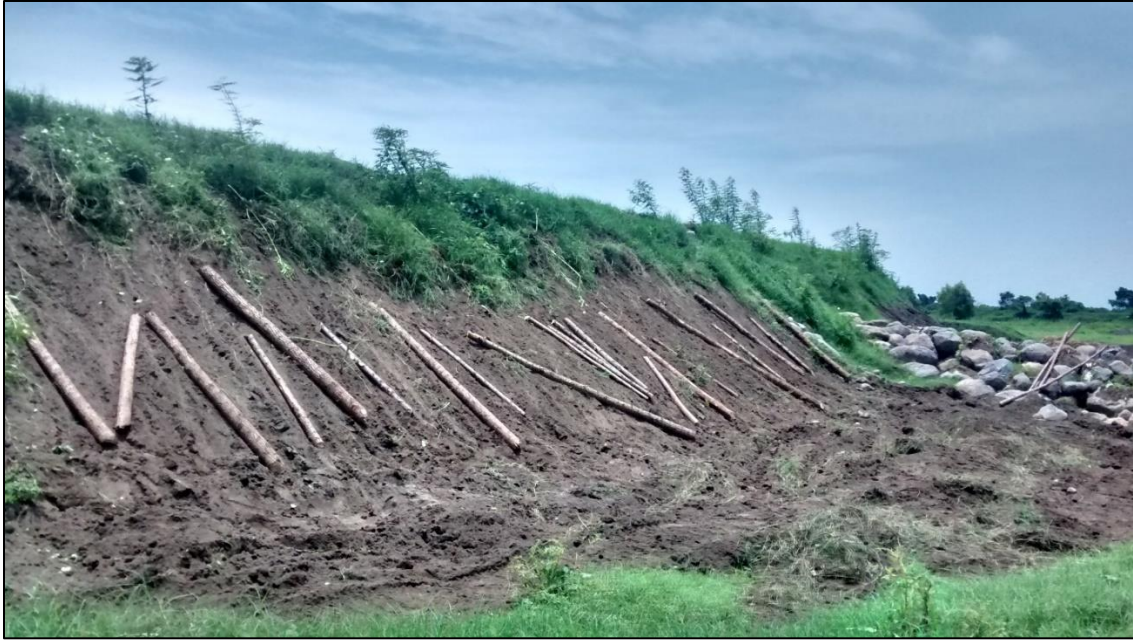
Fotografía 36 Preparación de los postes de madera para realizar el posteo en talud del tramo 1 Finca El Manantial
