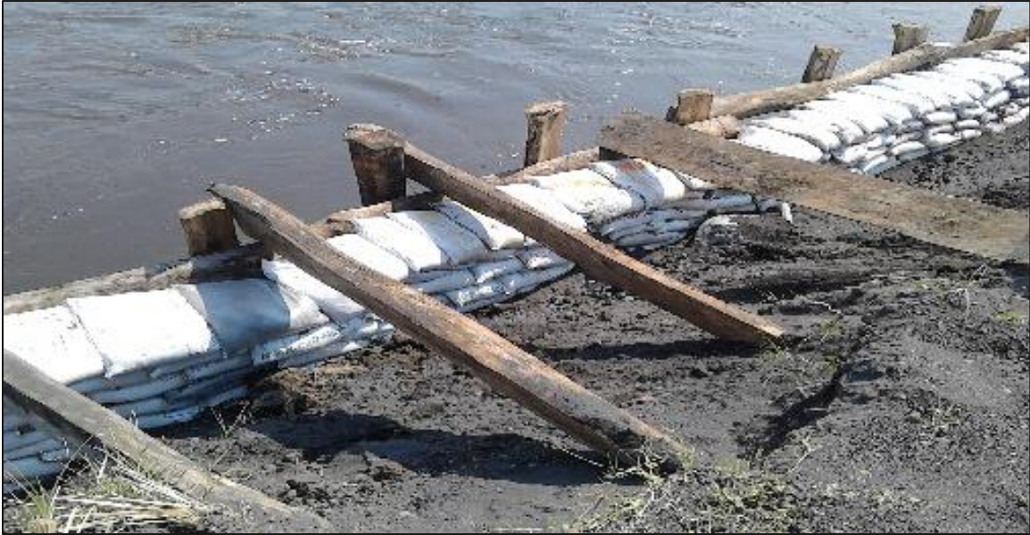
Fotografía 10 Disposición de refuerzo de la barrera de postes y lanceros en Finca El Rincón
