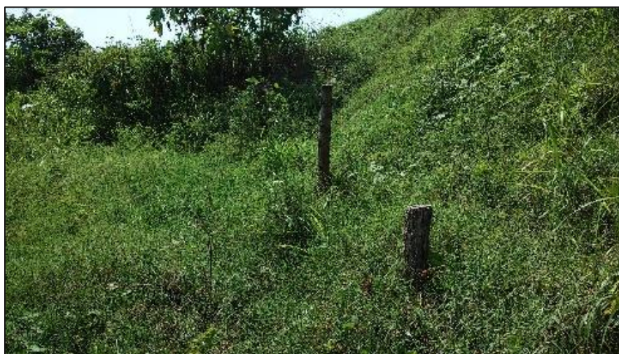
Fotografía 7 Técnica mixta de posteo y cubierta vegetal de Vetiver
