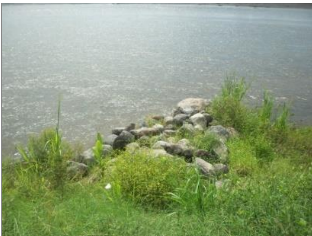
Fotografía 29 Refuerzo de talud con espigones de rocas
