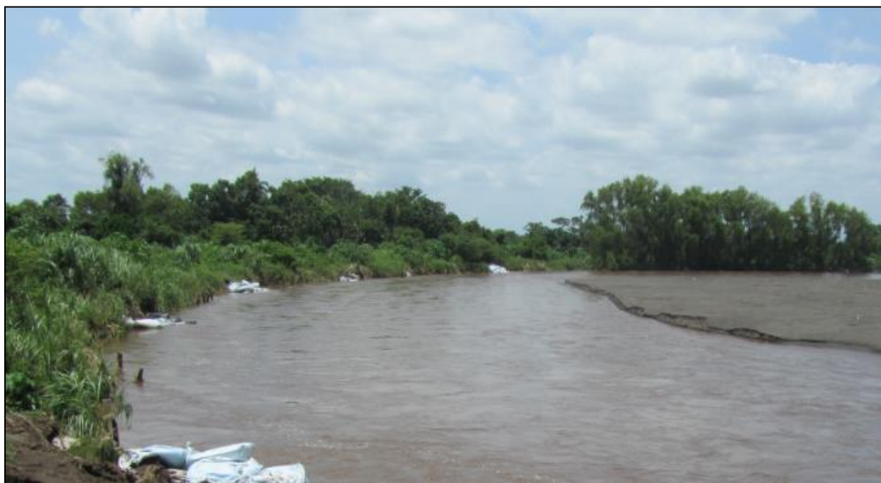
Fotografía 15 Panorámica de talud cubierta con material vegetal luego de su establecimiento
