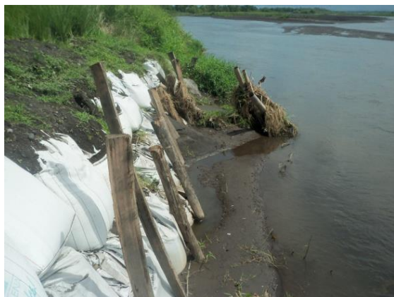
Fotografía 22 y Fotografía 23 Desempeño de la barrera de postes al impacto de la corriente
