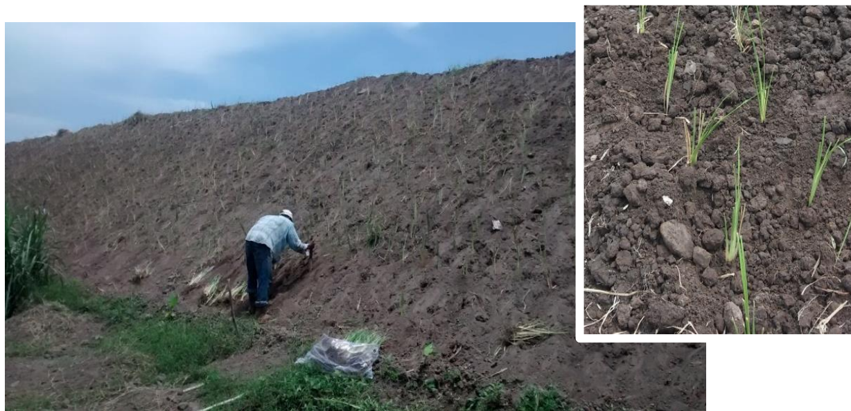
Fotografía 38 Establecimiento de plántulas de vetiver utilizando la técnica de tresbolillo para mayor estabilidad del talud
