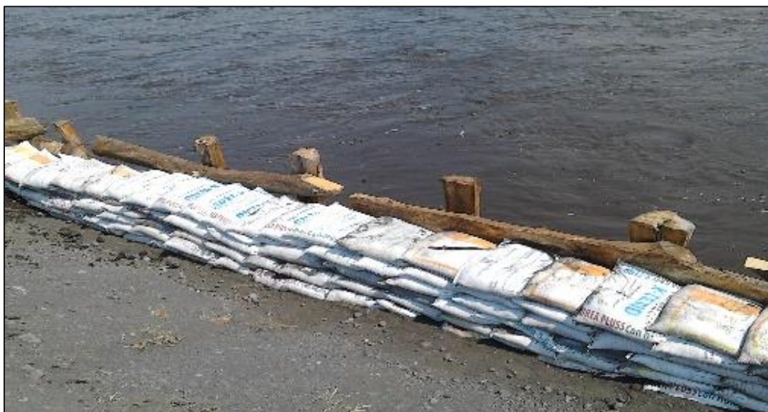
Fotografía 9 Refuerzo de la línea de posteo con sacos rellenos de arena en Finca El Rincón
