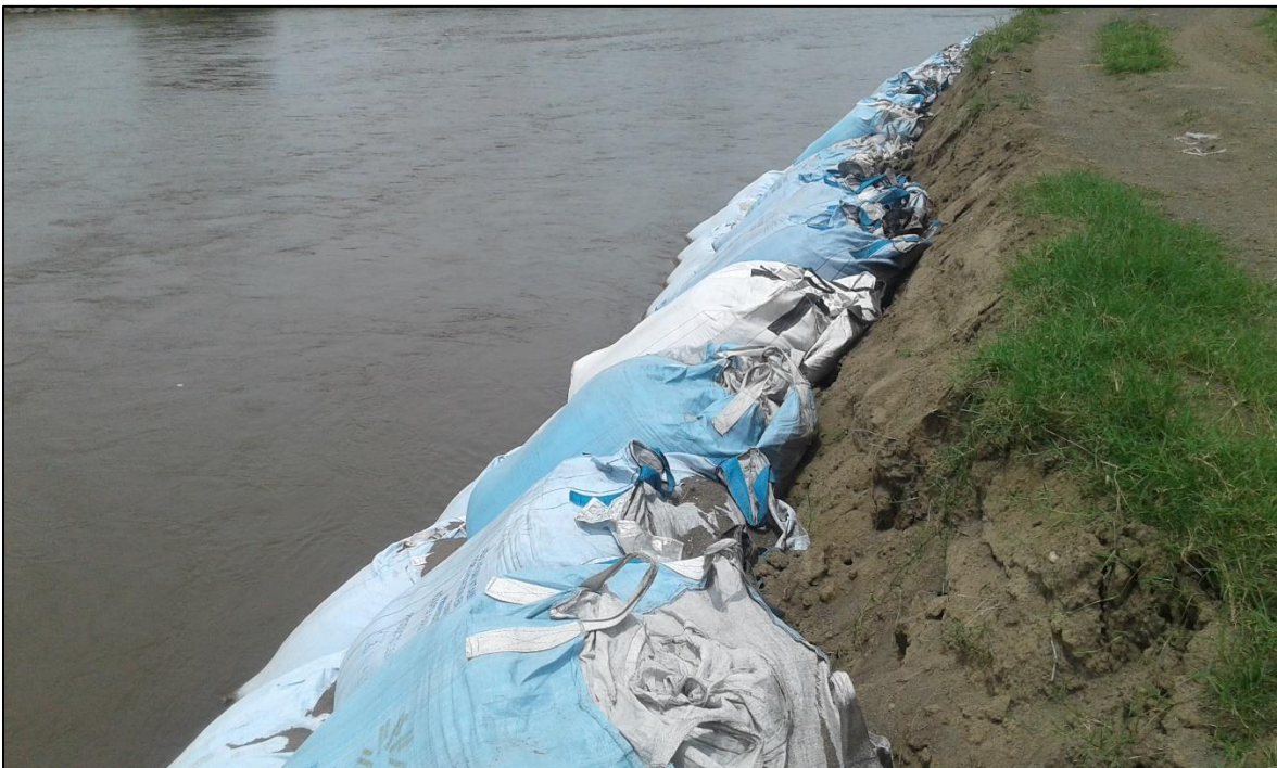
Fotografía 11 Refuerzo de borda con jumbos de arena en el río Coyolate
