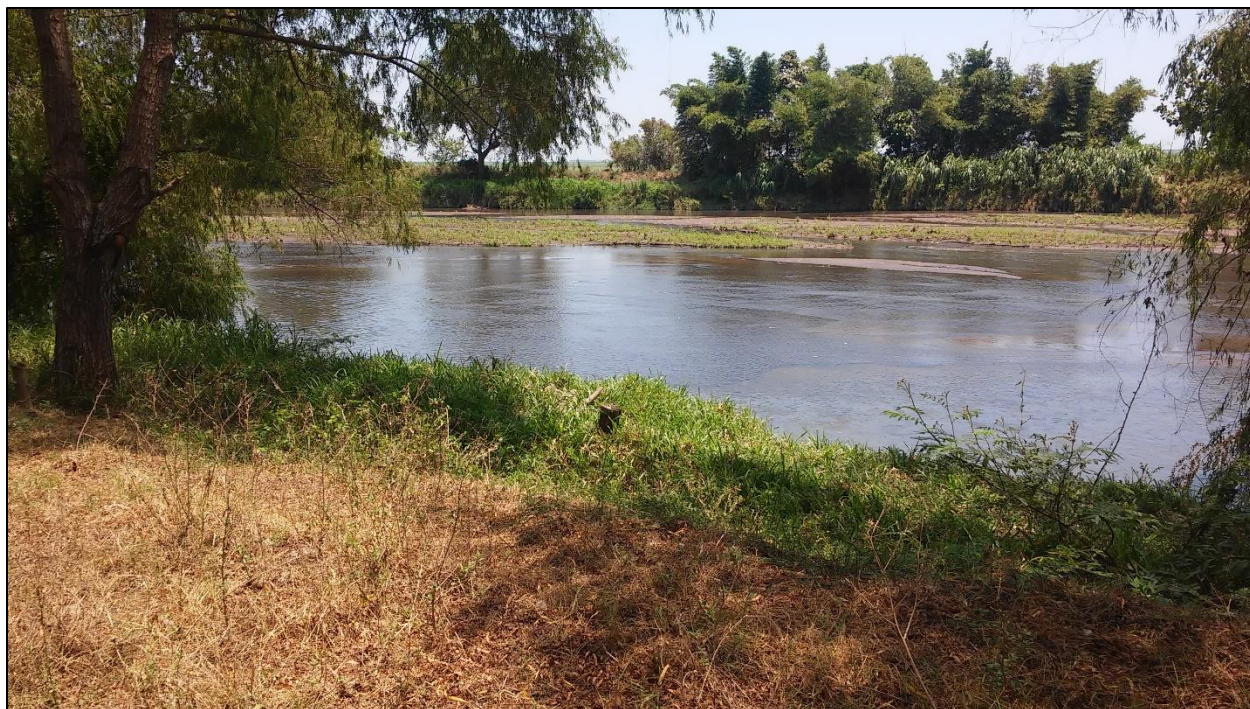
Fotografía 14 Mantenimiento de talud realizando buenas prácticas de manejo del material vegetal evitando el exceso crecimiento
