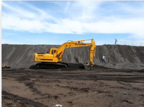
Foto 1. Bordas ejecutadas en el municipio de Masagua sobre el río Guacalate. Fuente: ICC.
