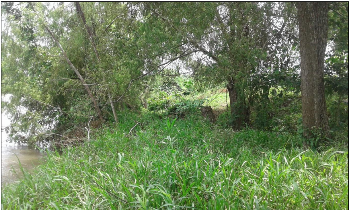
Fotografía 17 Cubierta vegetal natural en talud de borda
