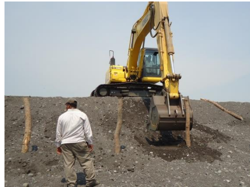
Fotografía 18 Introducción posteo vertical
