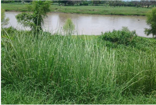
Fotografía 32 Revestimiento de vetiver
