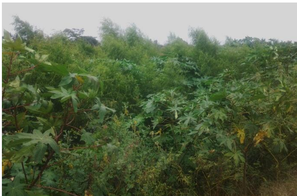
Fotografía 35 Aumento de la vegetación, resultado del mantenimiento del dique
