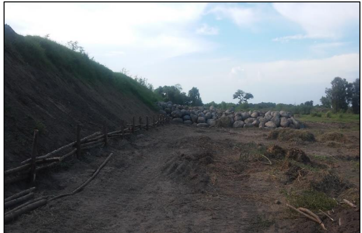
Fotografía 12 Borda con posteo y espigón de rocas
