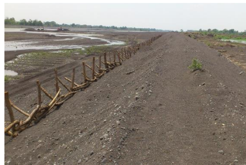
Fotografía 19 Posteo finalizado en la borda
