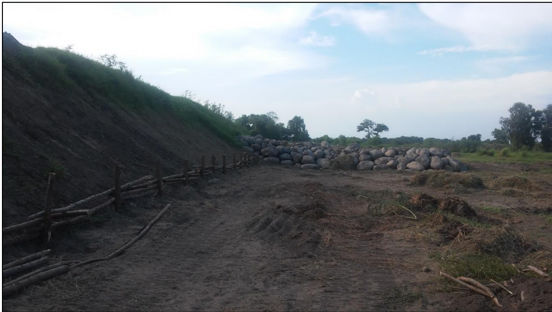
Fotografía 36 Preparación de los postes de madera para realizar el posteo en talud del tramo 1 Finca El Manantial
