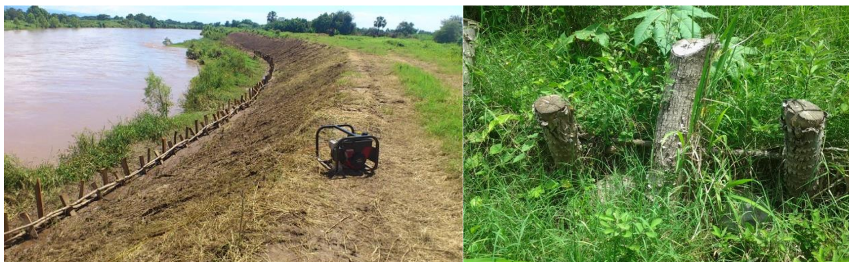
Fotografía 30 Perfil de borda en Aldea Las Pozas Fotografía 31 Detalle de técnica de posteo
