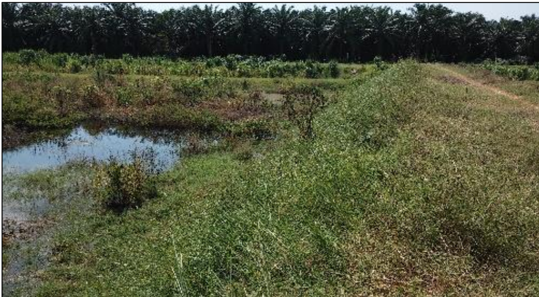
Fotografía 2 Dique con revestimiento vegetal en Finca El Manantial
