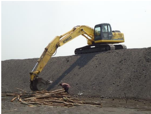
Fotografía 21 Perfilado de la borda
