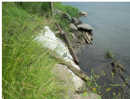
Fotografía 22 y Fotografía 23 Desempeño de la barrera de postes al impacto de la corriente
