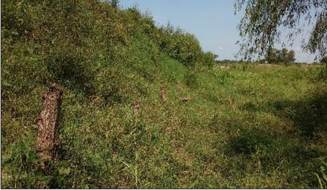
Fotografía 8 Dique estabilizado con técnica de bioingeniería, posteo y recubrimiento vegetal
