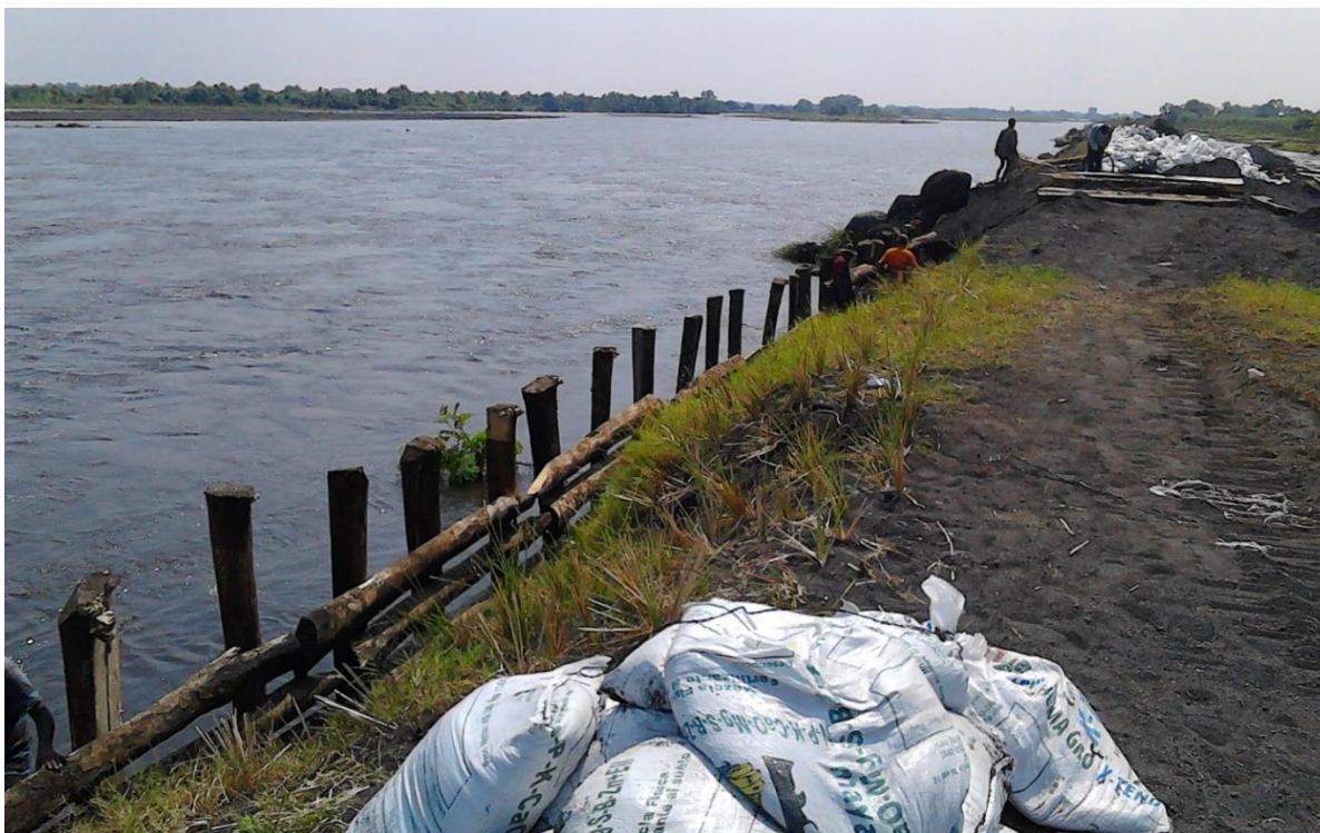
Fotografía 28 Colocación del posteado reforzado con sacos de arena
