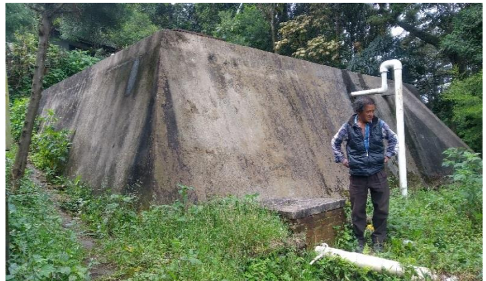
Figura 53A. Tanque de almacenamiento colonia Chapín
