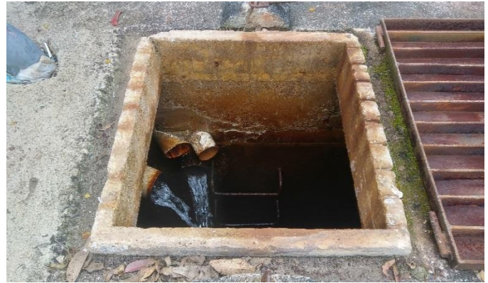
Figura 53A. Tanque de almacenamiento del campo
