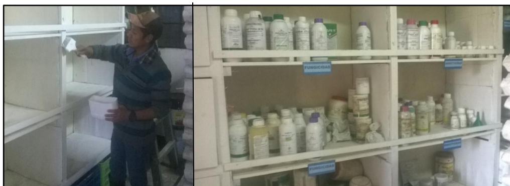
Figura 70. Recubrimiento con pintura blanca la estantería de agroquímicos. 2016
