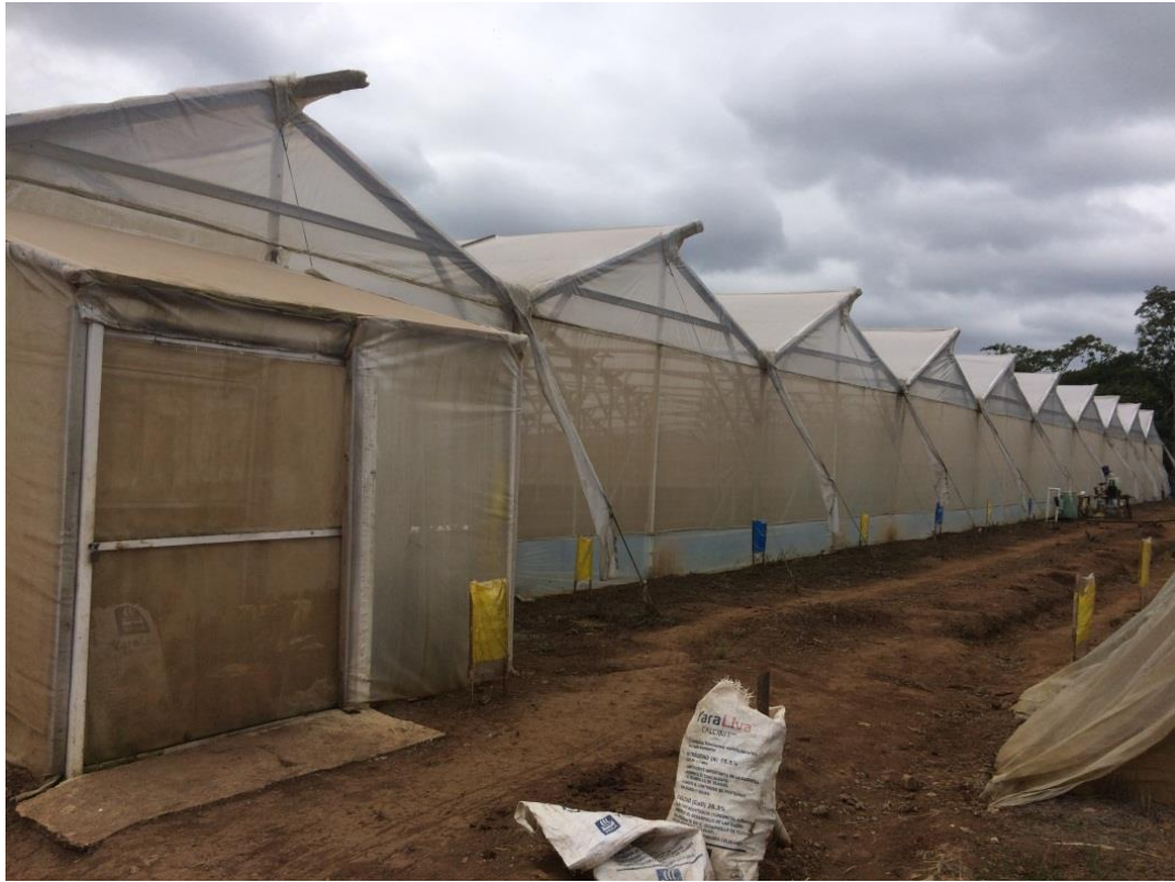
Fuente: elaboración propia. Figura 5. Invernadero capilla de dos agua.
