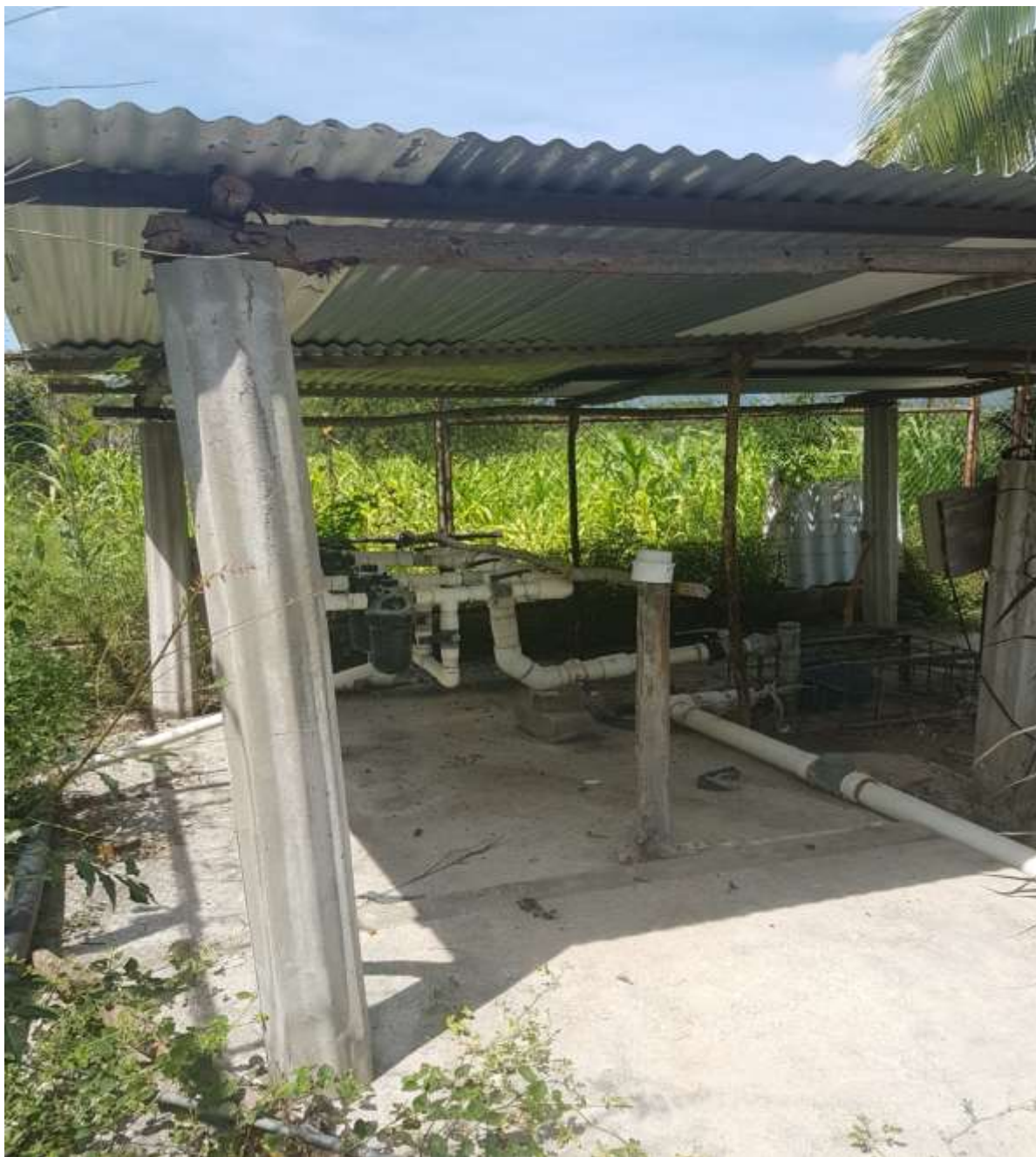
Fuente: elaboración propia, 2010. Figura 9. Obras de Infraestructura
