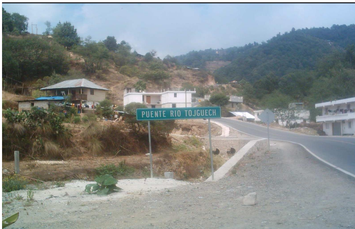
Figura 15. Puente vehicular de la cabecera de Tacana a las comunidades
