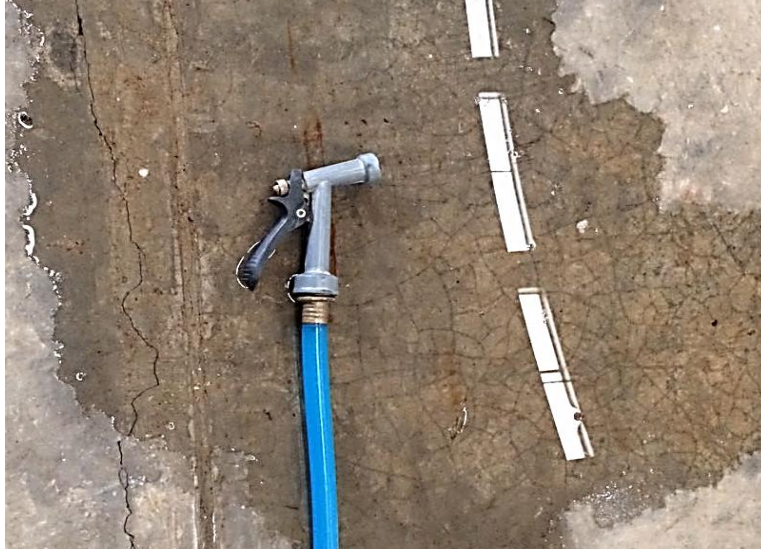
Figura 27. Pistola de agua a presión con fuga
