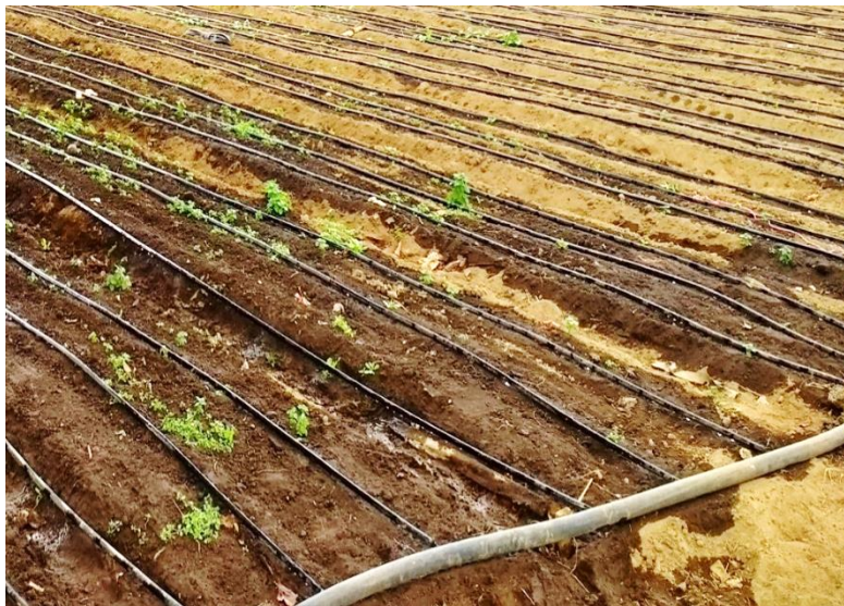
Figura 28. Tubería principal, líneas secundaria y goteros para riego
