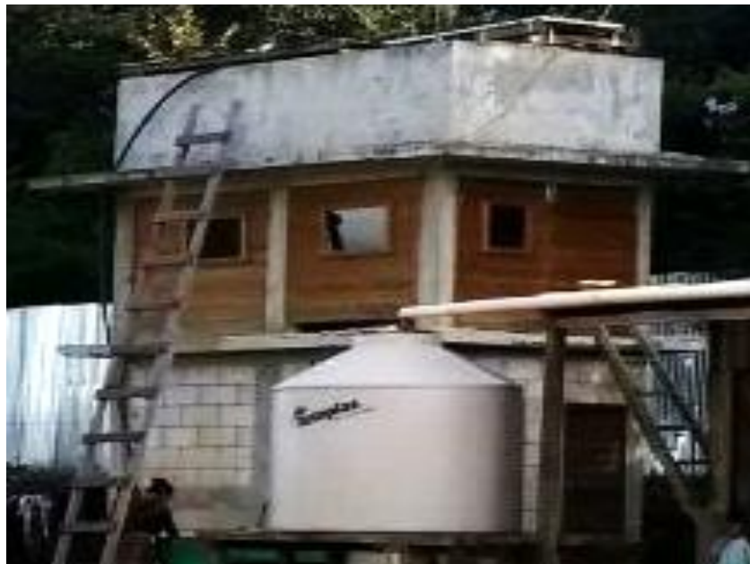
Figura 26. Tanque aéreo y depósito de plástico
