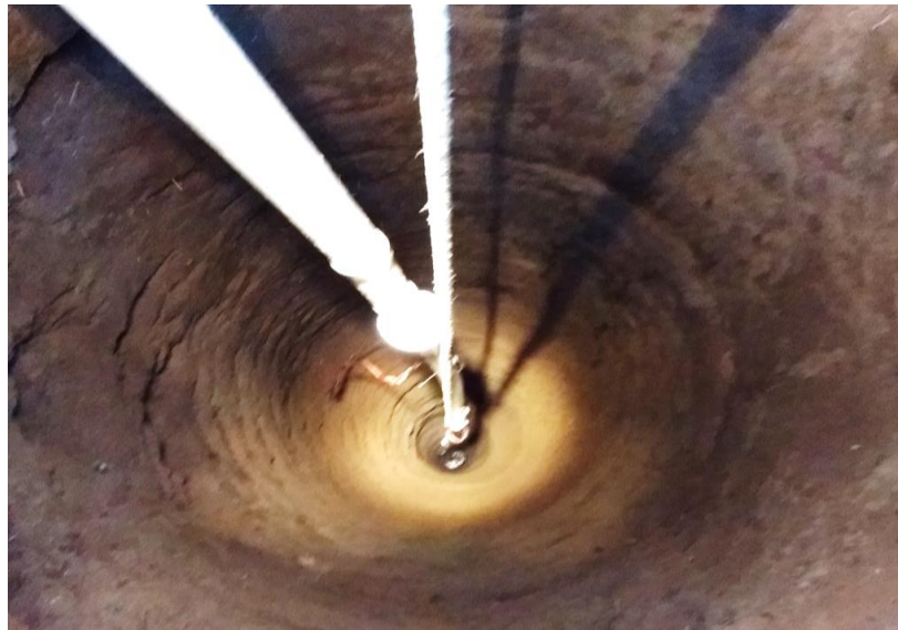
Figura 25. Vista interna del pozo artesanal
