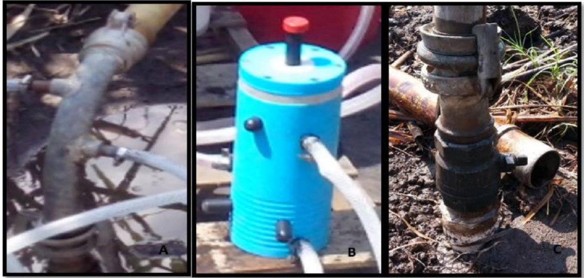
Figura 7. Sistema de Riego: A) Bomba de inyección "Eco-Fertic", B) Cuello de ganso, C) Válvulas de bola con acople mecánico
