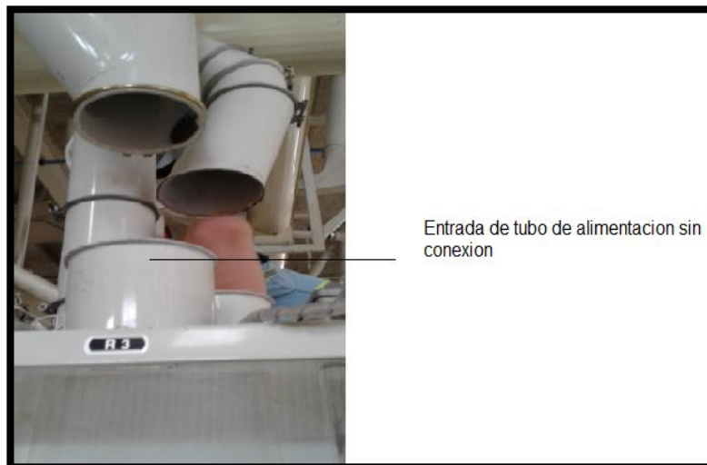
Imagen No. 2. Tubos de alimentación sin conexión
