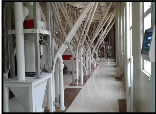
Imagen No. 1. Tubería a limpiar y Sanitizar
