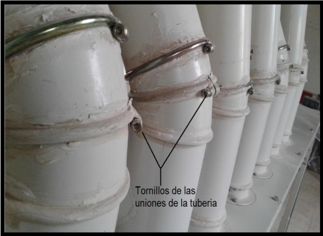
Imagen No. 2. Vista de los tornillos a desatornillar
