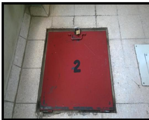
Imagen No. 4. Vista de la entrada superior de los silos
