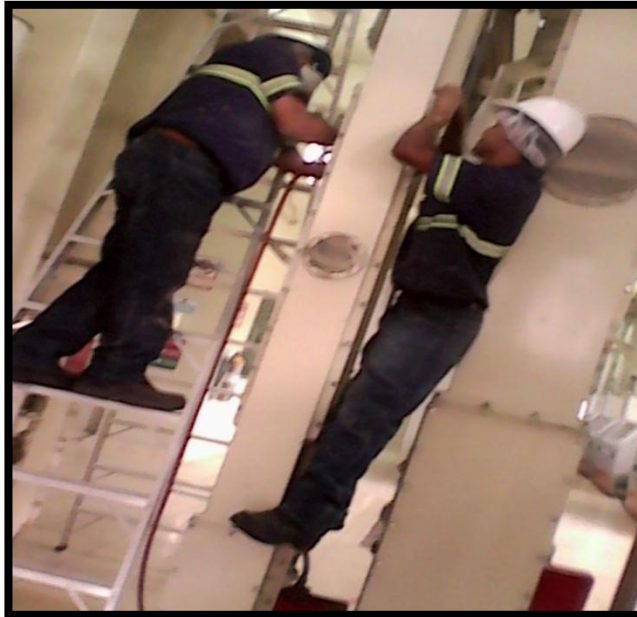
Imagen No. 2. Un operario sujeta las tuercas y otro desatornilla con la pistola de aire comprimido.
