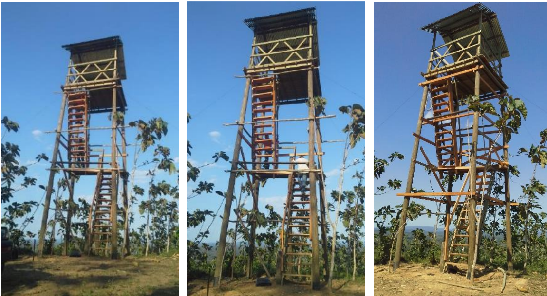
Figura 42. Fotografía de la fase final de la construcción de la torre de vigilancia finca El Recreo.
