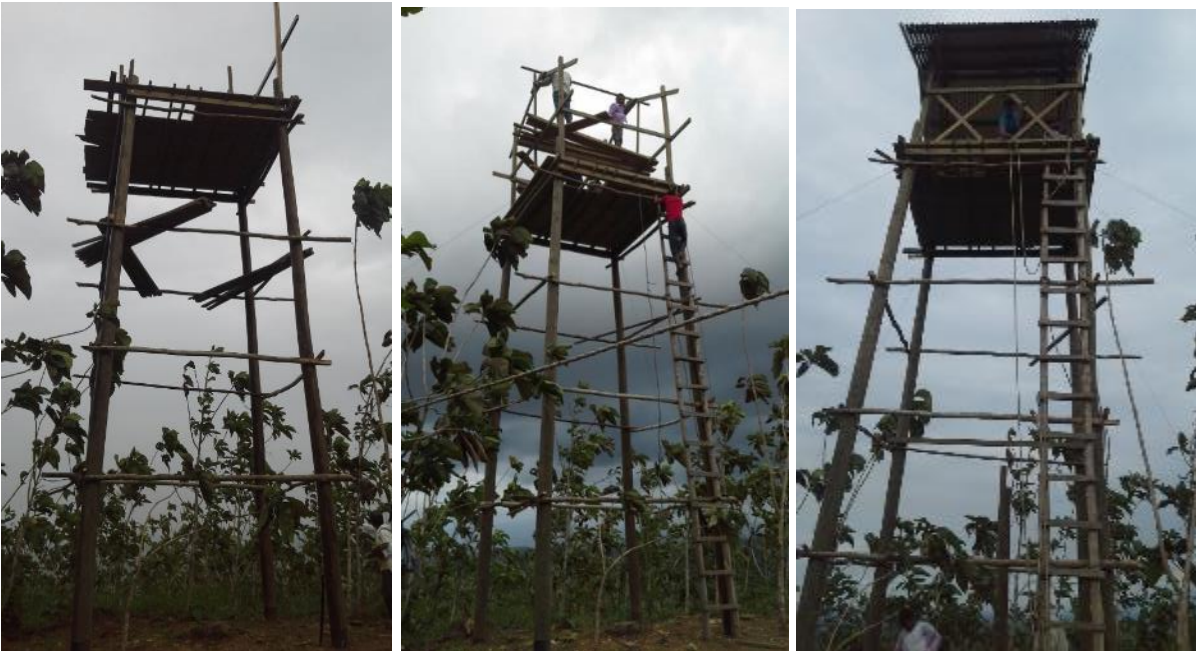
Figura 41. Fotografía de la construcción del techo de la torre de vigilancia finca El Recreo.
