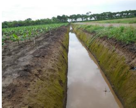
Figura 6 Canal de drenaje primario.
