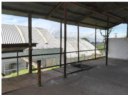
Figura 114. Refuerzo de estructura
