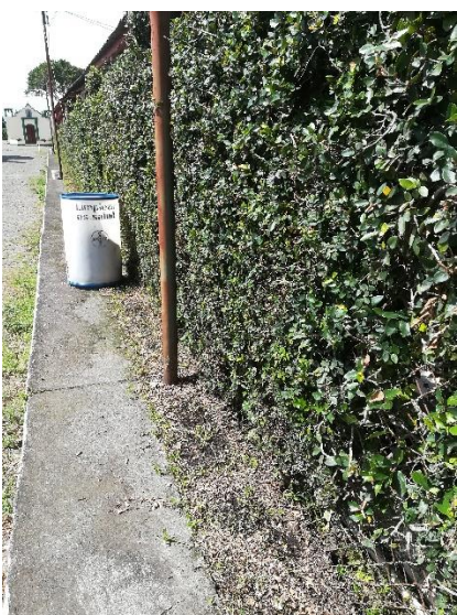
Figura 115. Mantenimiento muro vivo
