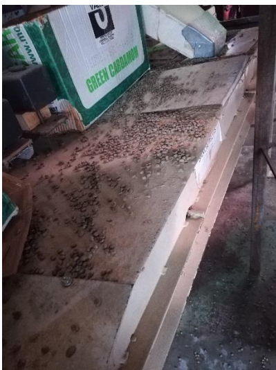
Figura 102. Deficiencia en los elevadores delta
