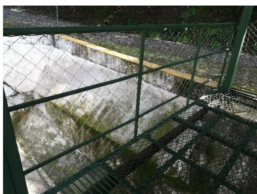
Figura 111. Refuerzo de estructura
