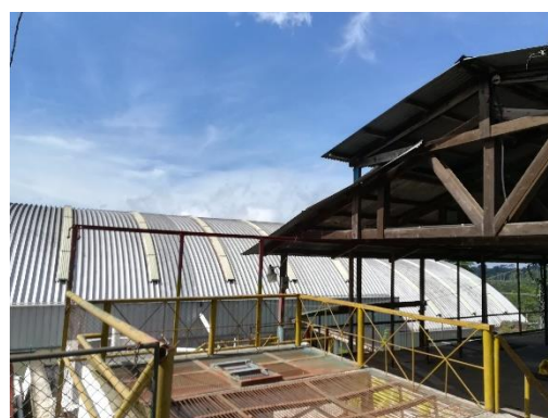
Figura 113. Eliminación de estructura de riesgo
