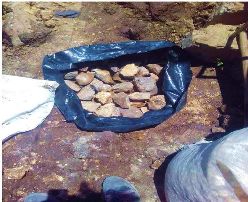
Figura 19A. Incorporación de materiales filtrantes.
