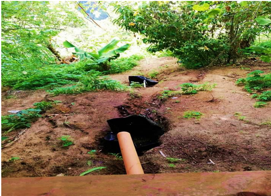
Figura 21A. Conducción de agua del primer filtro al segundo.
