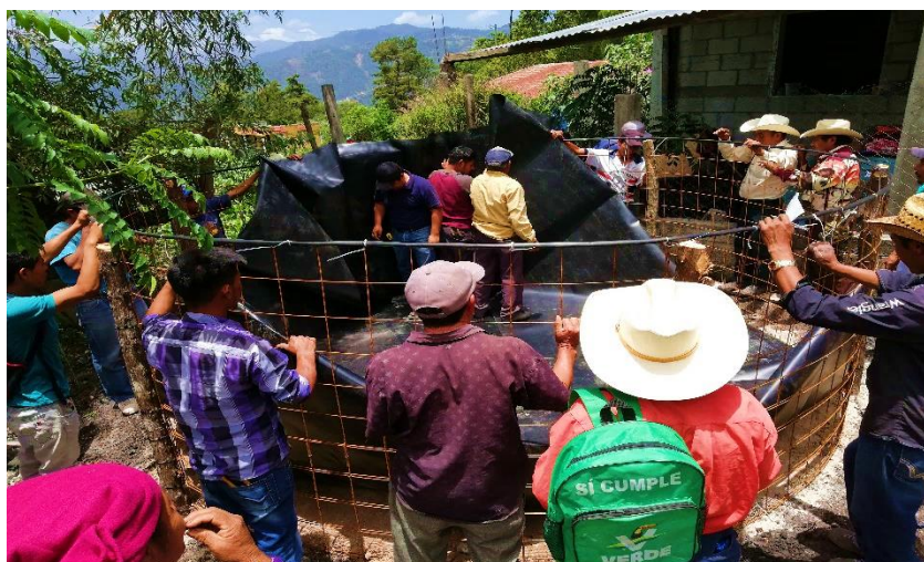
Figura 40. Armado de cosechador de agua de lluvia.
