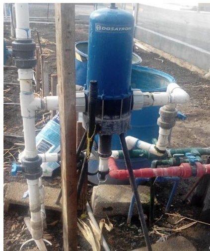
Figura 7. Inyector de solución nutritiva en el invernadero marca Dosatron®
