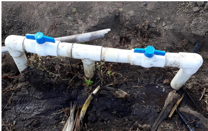
Figura 9. Modelo de caballete doble de para secciones de riego.
