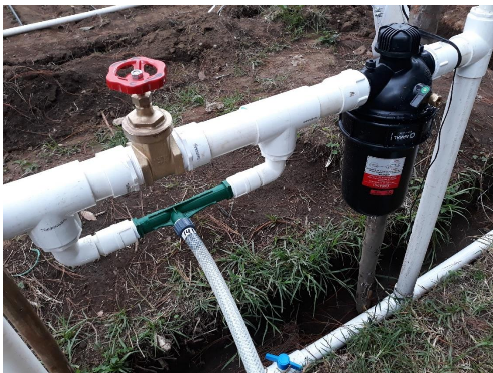
Figura 51. Sistema de inyección de fertilizantes y productos fitosanitarios en finca La Orgánica
