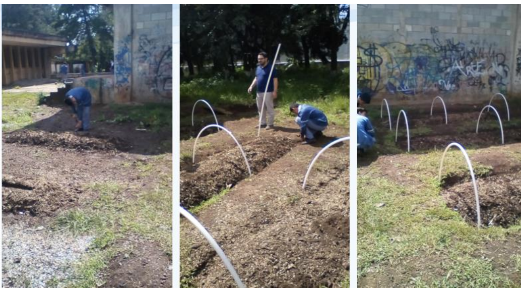
Figura 57. Instalación de microtúneles por estudiantes del taller de Metales
