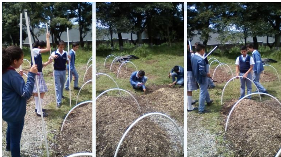
Figura 58. Instalación de microtúneles por estudiantes colaboradores
