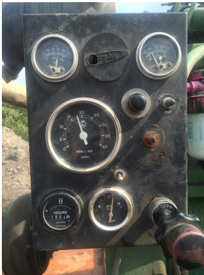
Figura 129. Medición de parámetros de operación de motor durante prueba
