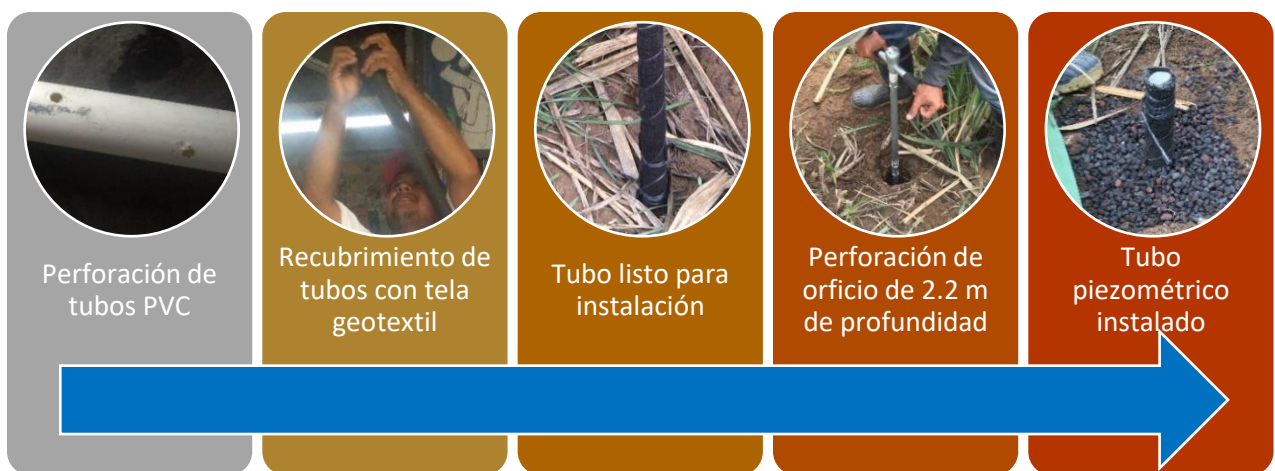
Figura 50. Proceso de instalación de tubos piezométricos en campo
