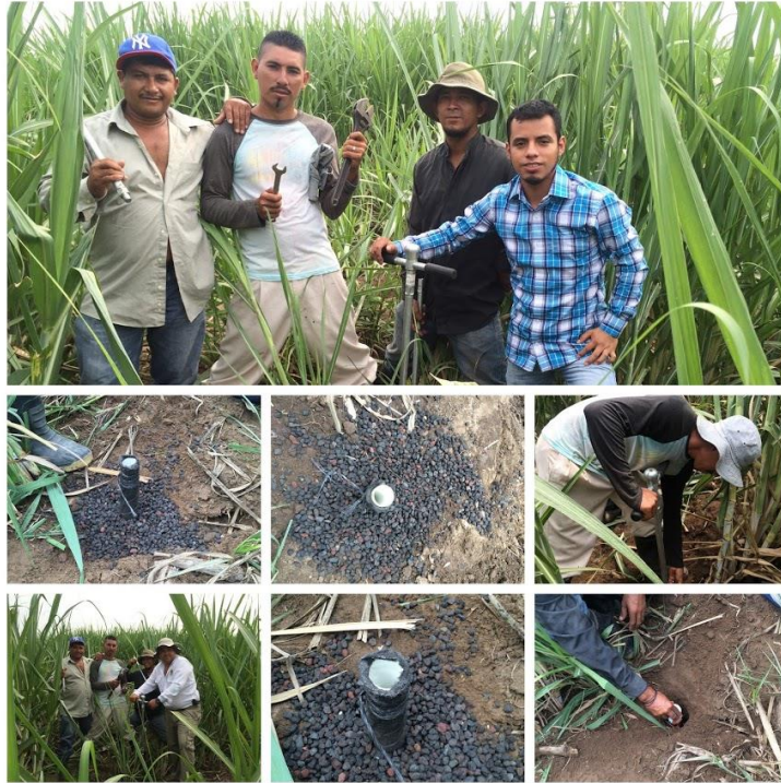
Figura 108A. Instalación de tubos piezométricos para monitoreo de nivel freático en área de investigación
