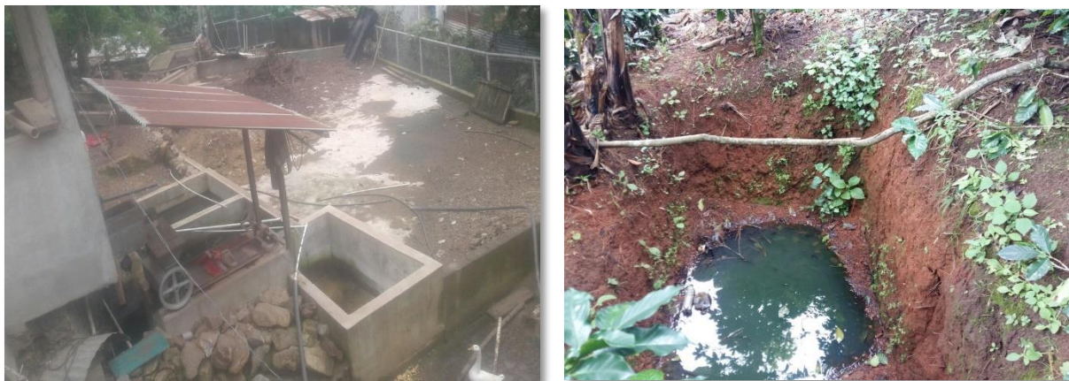
Figura 36. Inspección de fosas y de la infraestructura.
