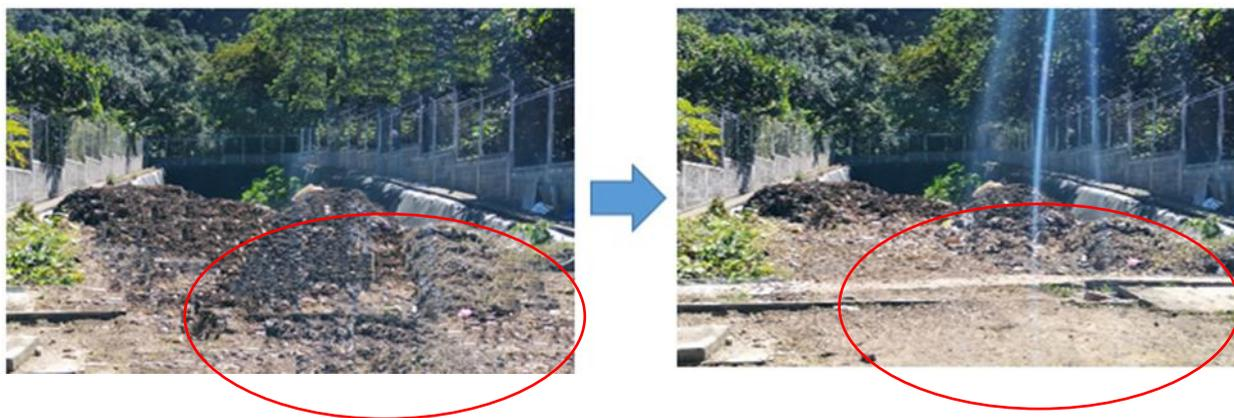
Figura 28. Despeje de área de rampa para la disposición final de los desechos sólidos.
