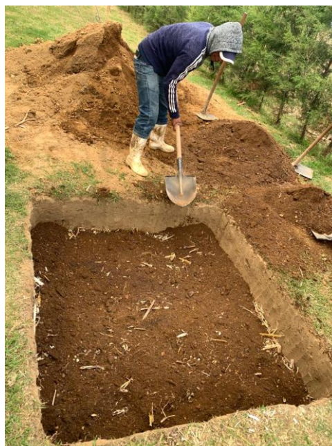
Fuente: elaboración propia, 2019. Figura 74A. Llenado del agujero con la mezcla de suelo, broza y caña.
