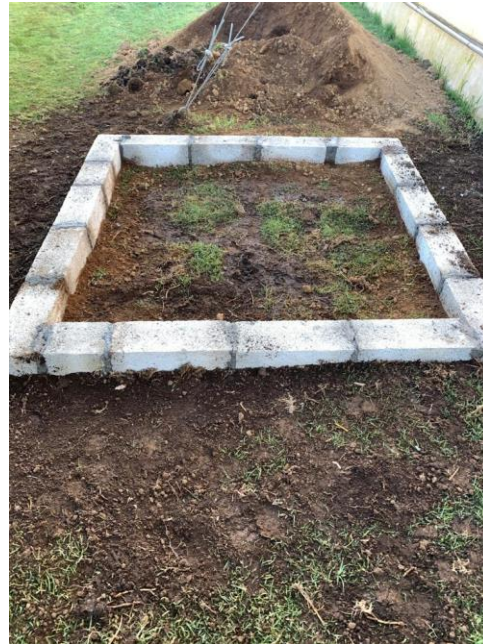
Fuente: elaboración propia, 2019. Figura 77A. Bordillo construido de block en la cama biológica.
