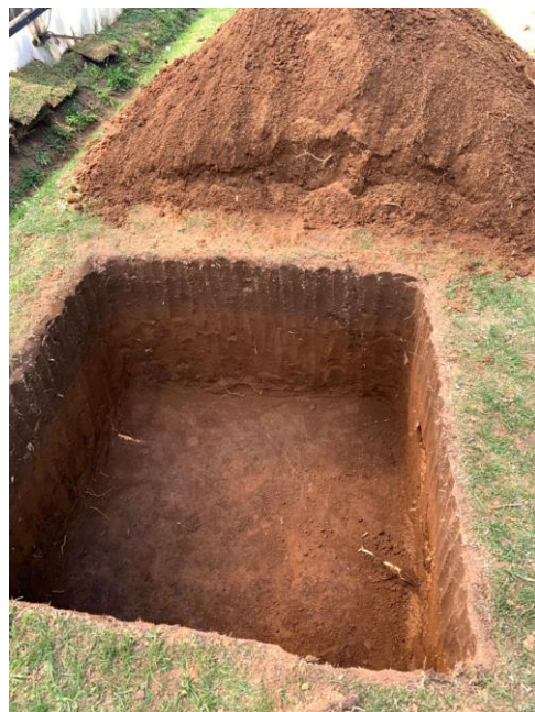
Fuente: elaboración propia, 2019. Figura 73A. Finalización del agujero para la cama biológica.
