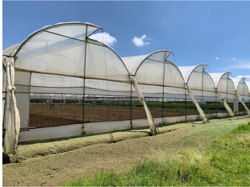
Fuente: elaboración propia, 2019. Figura 4. Invernadero tipo multica pilla.
