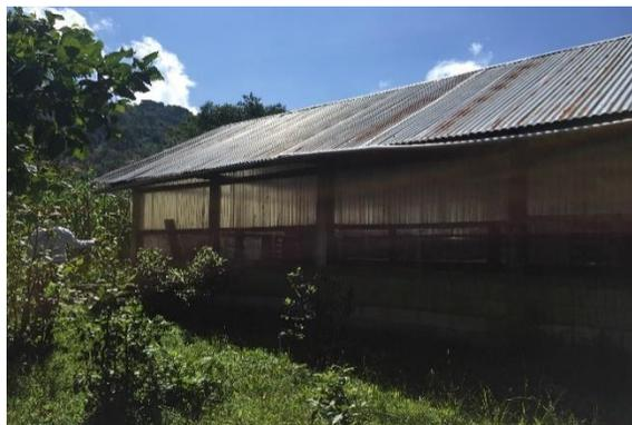
Figura 100. Infraestructura mejorada construida con material de lámina de aluminio, lamina plástica, malla antiviral y bases de concreto para la producción de semilla de papa.
