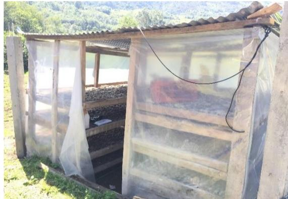
Figura 98. infraestructura construida con material plástico y madera para la producción de semilla de papa.
