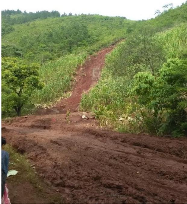
Figura 10. *Derrumbes sobre carretera por falta de cobertura forestal.*
