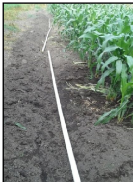
Figura 37. Instalación de tubería secundaria para el sistema de riego en la parcela de maíz.
