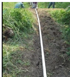
Figura 36. Instalación de tubería principal y válvulas para los dos sectores de riego.
