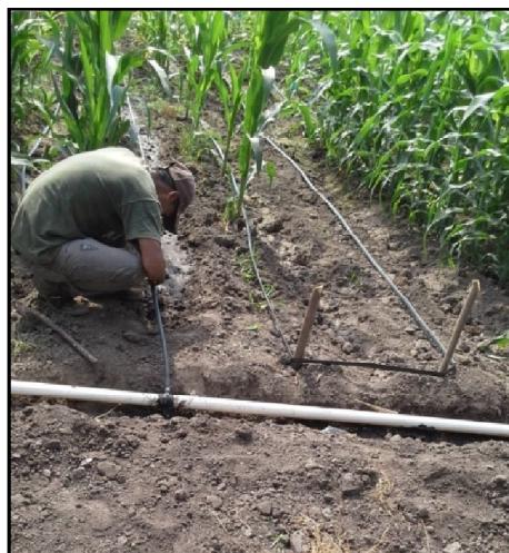
Figura 38. Instalación de mangueras de riego en la parcela de maíz.
