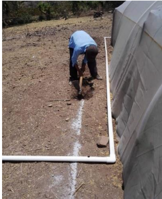
Figura 15. Zanjeo de tubería: a) tubería PVC
