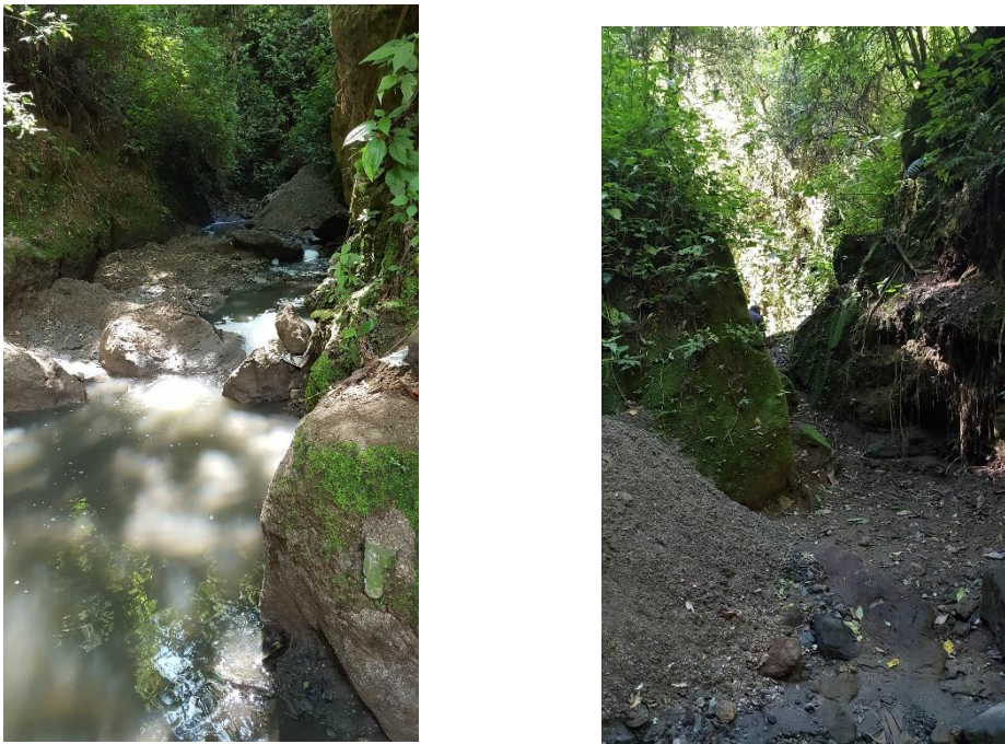
Figura 49. Cauce del río Chinimayá donde se aprecia rocas y suelo compactado.
