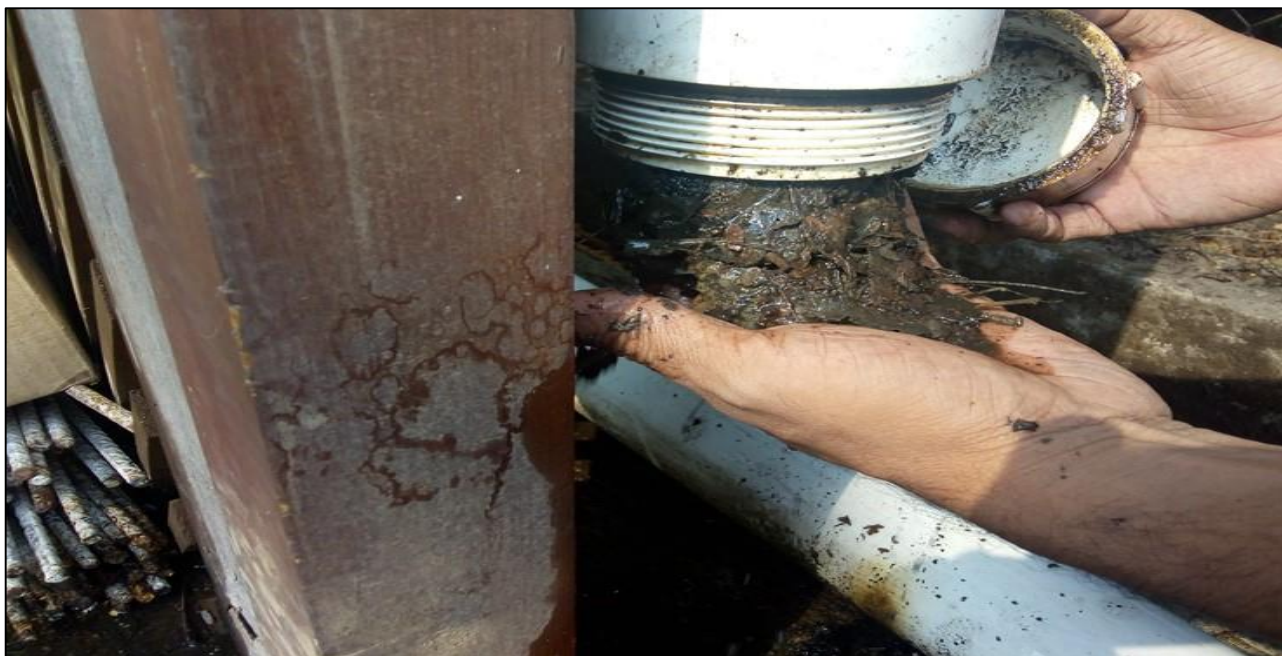
Figura 126A. Limpieza de sedimentos en bajadas de un sistema de agua y almacenamiento.
