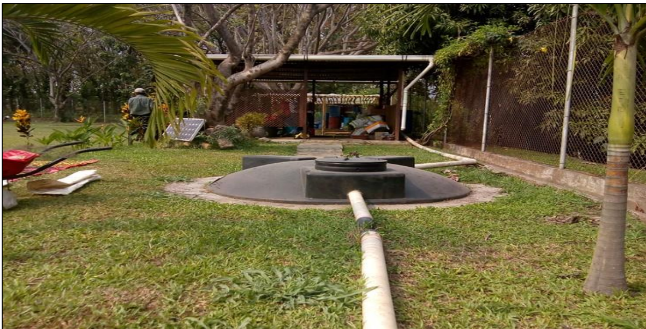
Figura 125A. Sistema de captación y almacenamiento de agua de lluvia de la Finca Camantulul, 2018.
