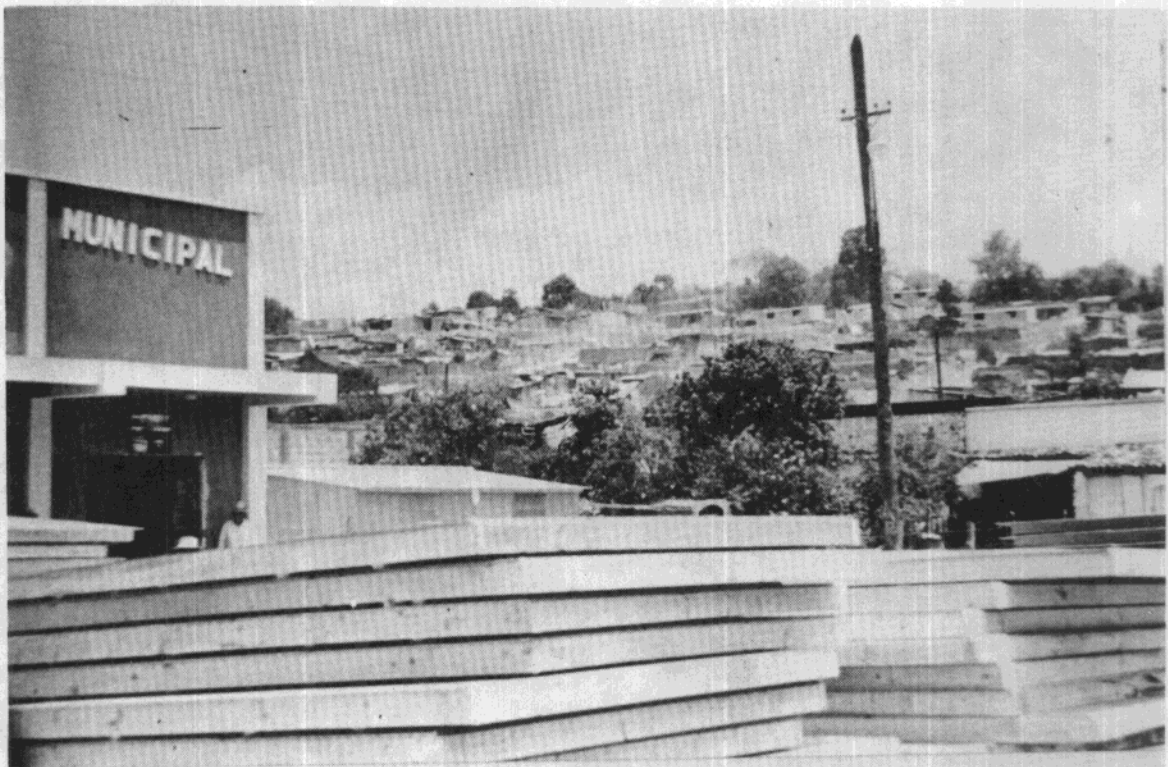
ALMACENAMIENTO DE PAREDES
