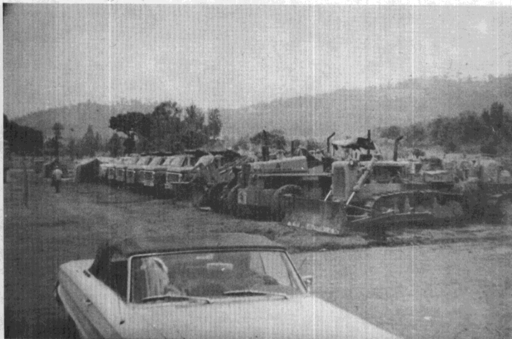
PARTE DE LA MAQUINARIA USADA PARA DESCOMBRAMIENTO Y NIVEL DE CALLES Y TERRENOS.
