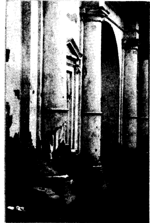
ERMITA DE LOS REMEDIOS COLUMNAS EN LA FACHADA PRINCIPAL
