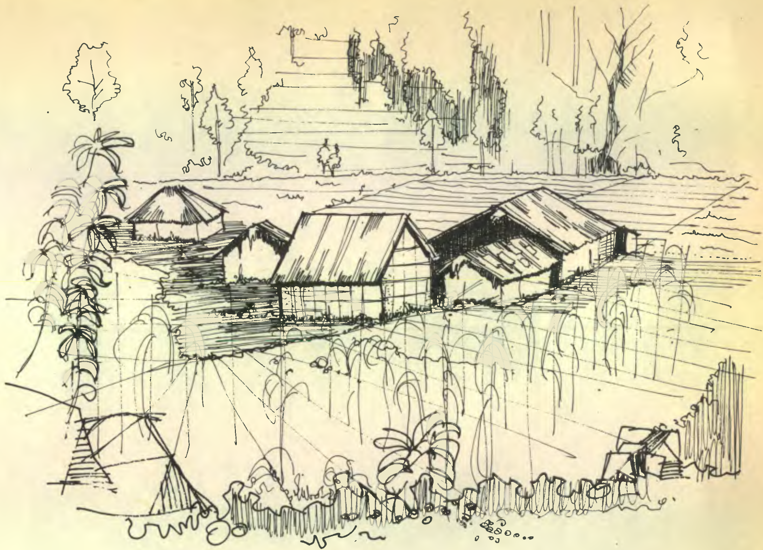
VISTA A MEDIA DISTANCIA DE VIVIENDAS RURALES. FIGURA 2. DE TIPO RUSTICO E IMPROVISADO, DE ADOBE, BAJARE- QUE Y PALOS DE CERCO EN PAREDES Y PAJON EN EL TECHO (DE DOS Y CUATRO AGUAS). EN GUATE- MALA EL 47.7% DE V.R. ES DE TIPO RUSTICO Y EL 8.7% ES DE TIPO IMPROVISADO. —
