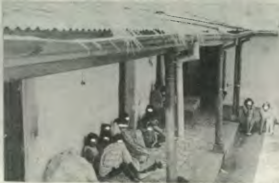
CORREDOR CENTRO DETENCION MUJERES
