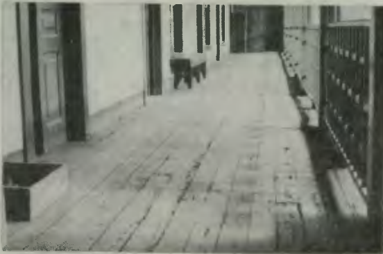
PASILLO ENTREPISO 1er. CUERPO.
