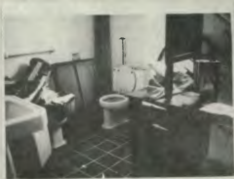
DEPOSITO DE PRUEBAS Y SERVICIOS SANITARIOS JUZGADO 8. DE PAZ PENAL.
