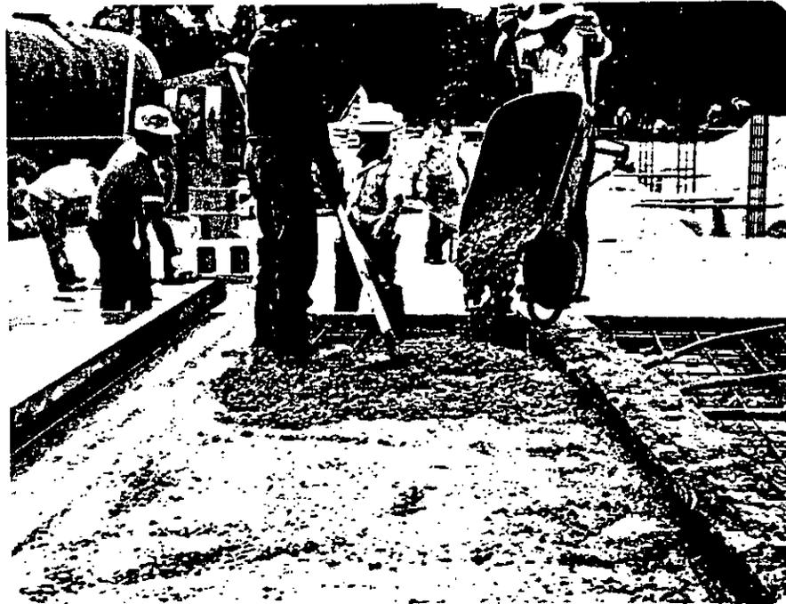
Estas áreas de terreno se preparan para que sobre su superficie nivelada se proceda a la fundición de los paneles en sus respectivos encofrados, que corresponderán de ese sector determinado de la construcción.
