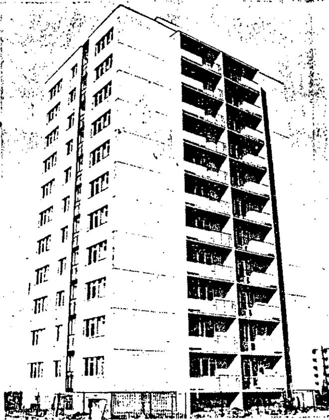
*Fig. 18.39. — Torre de once plantas realizada mediante el sistema Szczecinski.*
