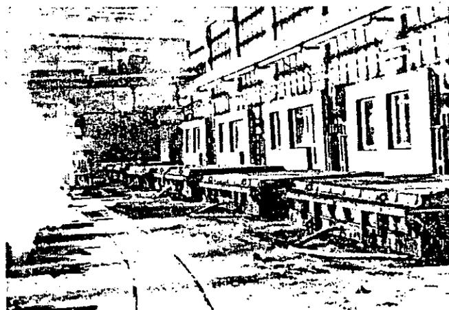
*Fig. 18.45.— Depósito de paneles de fachada a los que se le incorpora el acristalado.*
