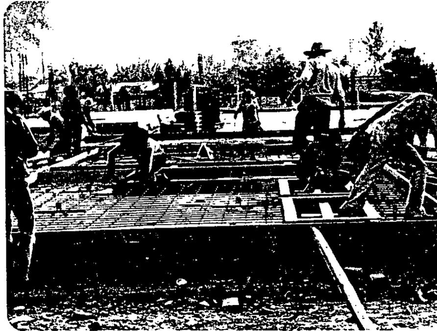
El trabajo de fundición de los paneles está programado para hacerse simultáneamente con el de excavación, cimentación y estructura, el cual se realiza por sistema de construcción tradicional con tiempos programados de ejecución, para que al finalizarse, ambos trabajos, pueda iniciarse el de la colocación y fijación de los paneles en su lugar definitivo dentro del proyecto, -- sin pérdida de tiempo.
