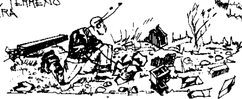
LIMPIAR EL TERRENO DE TODO MATERIAL QUE IMPIDA EL TRAZO QUE PRECEDE AL ZANQUEO, COMO: PIEDRAS, TERRONES, O BIEN; MATERIAL EN DESECHO DE CONSTRUCCION QUE ANTERIORMENTE EXISTIA, COMO: PEDAZOS DE BLOCK, LADRILLO ETC...
