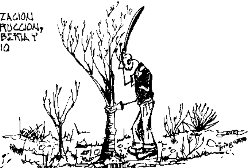
ELIMINACION DE TODO ARBUSTO, MATAS Y ARBOLES QUE OBSTACULICEN EL DESARROLLO DE LA CONSTRUCCION
