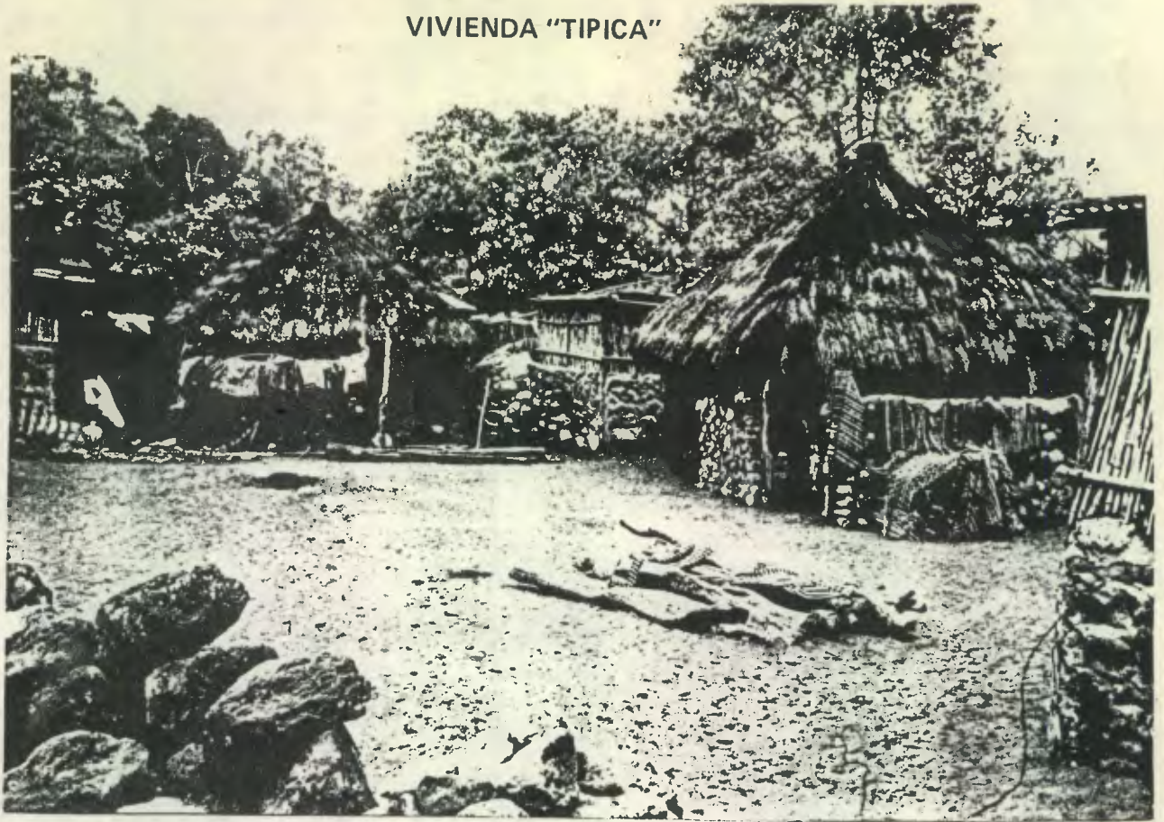
VISTA DE LAS VIVIENDAS EN CONJUNTO F. No. 8
