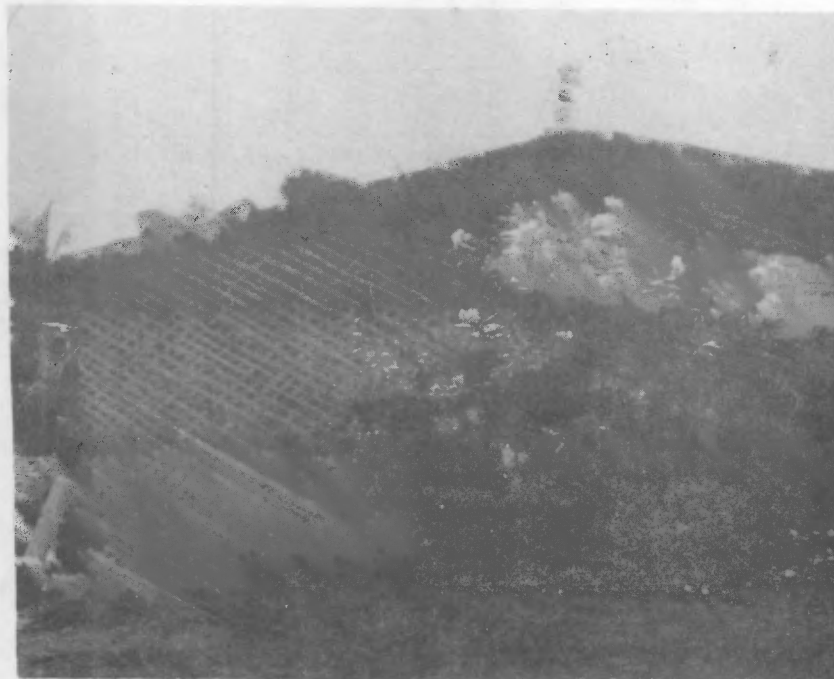
Foto No.26. Tabique en comercio, las medias varas han sido clavadas en sentido diagonal. Jalbataqua, Jutiapa.
