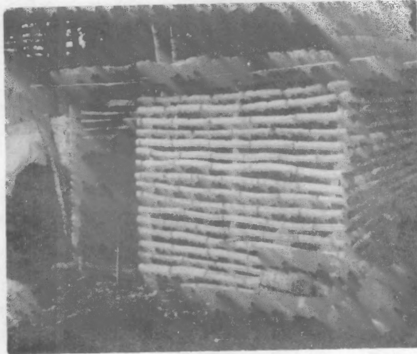
Foto No.25. Construcción de gallinero con varas rajadas de bambú. Barberena, Santa Rosa.
