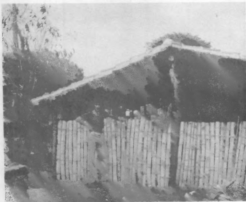
Foto No.24. Uso de bambú en cercas. Las varas enteras van amarradas con a lambre. Jutiapa.
