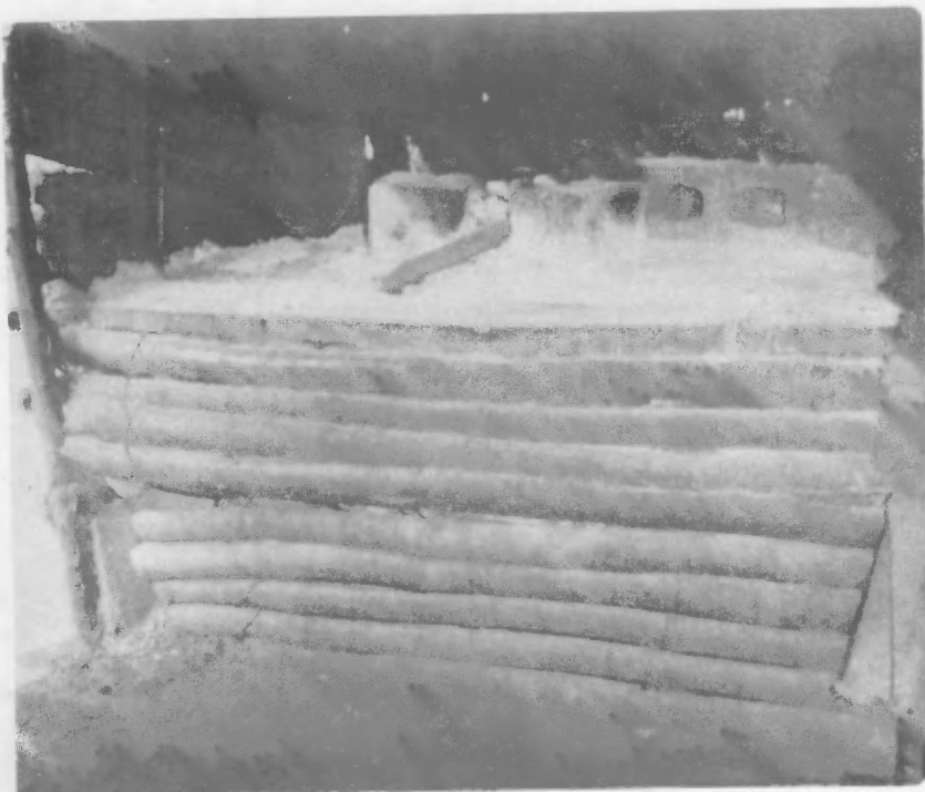
Foto No.23. Vivienda tipo 3. Tarima de fogón hecha con varas de bambú.
