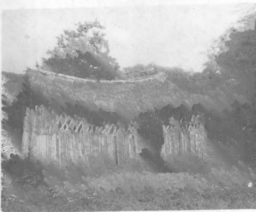
Foto No.28. Bodega construída con varas de bambú. Santa Rosa.
