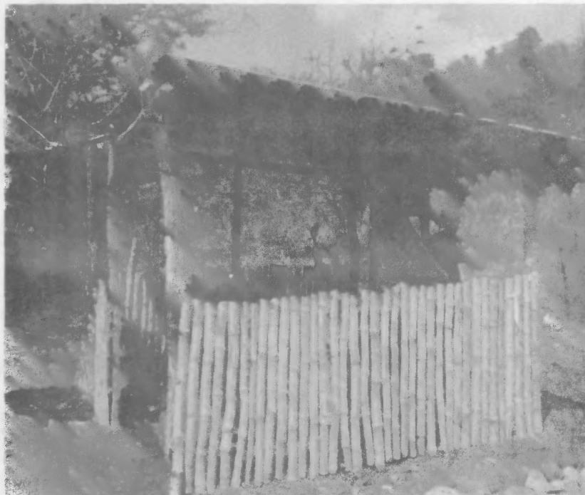
Foto No.27. Uso de bambú para construir pequeños tabiques para caseta de ventas. Jalpataqua, Jutiapa.
