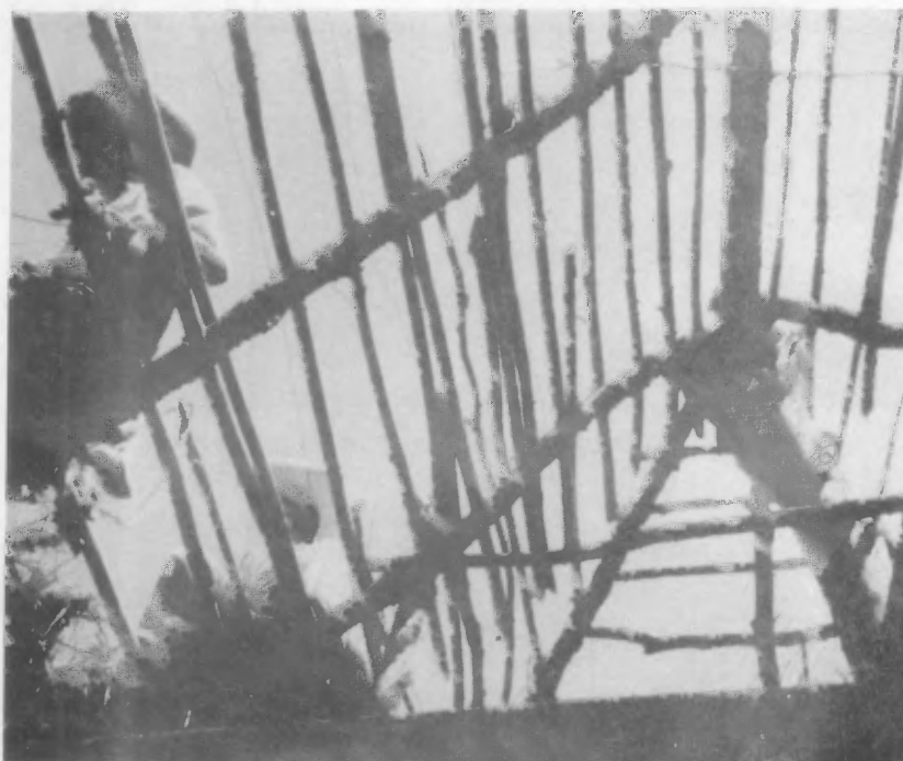
Foto No.21 Estructura de techo con bambú variedad tuldoides. Jutiapa.
