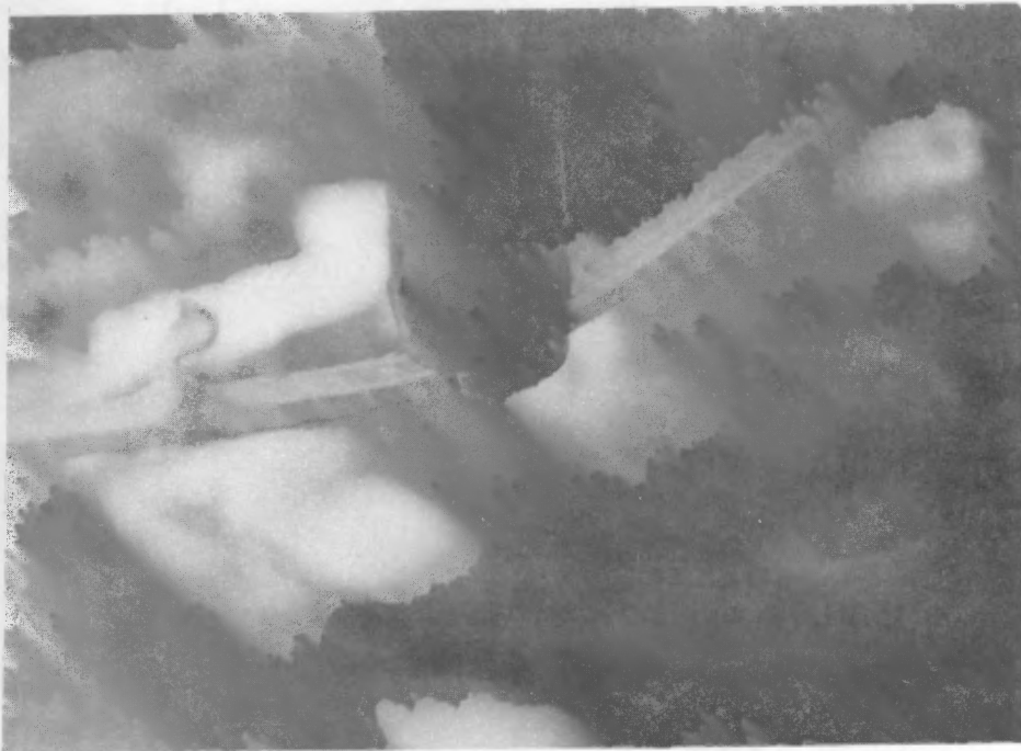
Foto No.34 Unión del poste central de la armadura al tensor, por medio de ranura hecha en el poste.
