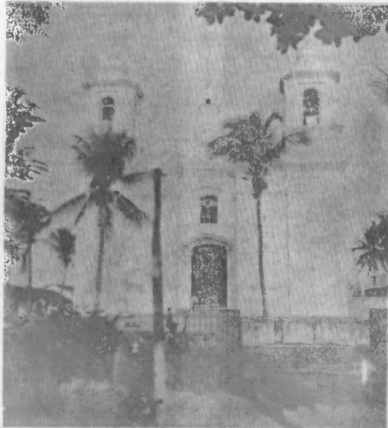
EN ESTA EPOCA EL PARQUE ESTABA CIRCULADO POR UNA BARANDA, LA CUAL EXISTE AUN EN EL PERIMETRO DE LA PARROQUIA. DESCONOCIDA SU DESAPARICION.
