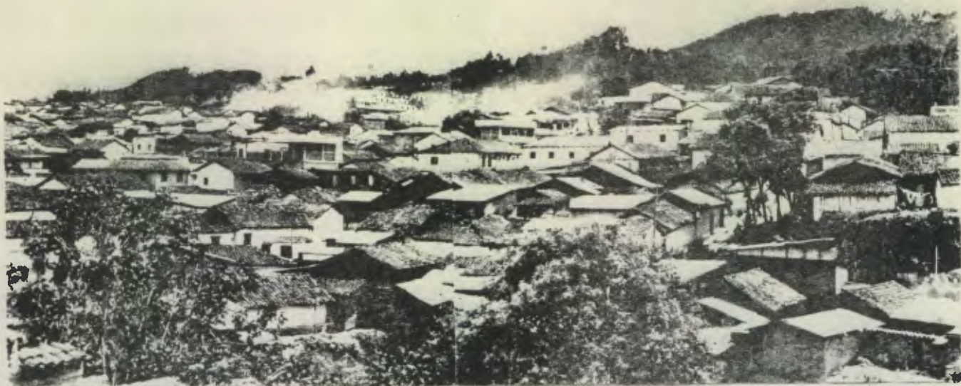
Vista parcial de la Villa de Chichicasteñango (nótese el predominio de la teja y el adobe como elementos constructivos)
