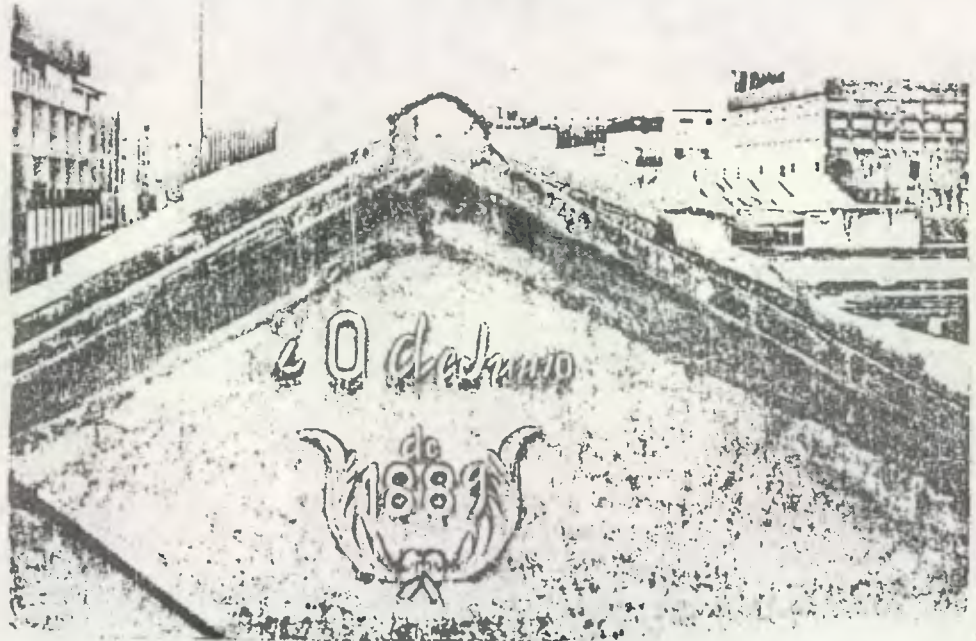
EL MOJINETE DEL LADO NORTE MUESTRA LA FECHA DE CONSTRUCCION DEL EDIFICIO
