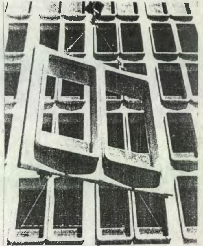
*En estas dos fotografías se puede ver claramente, la uniformidad en la fachada, la modulación y el uso de medidas estándar, para aprovechar al máximo los prefabricados.*
