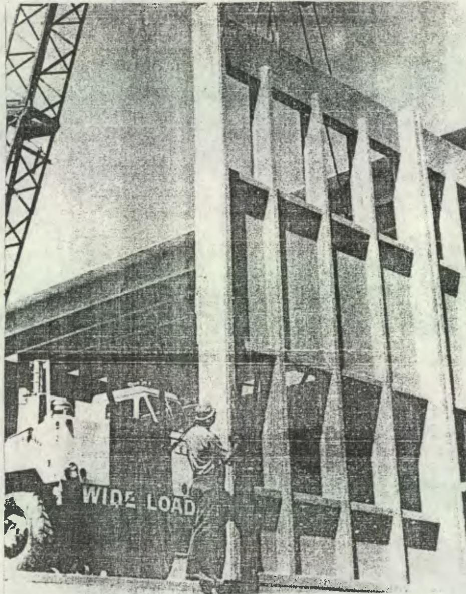
*En la fotografía, podemos ver la construcción de un edificio comercial construido a base de fachadas prefabricadas estructurales; así como su techo que es a base de vigas tipo doble "T" pretensadas.*
