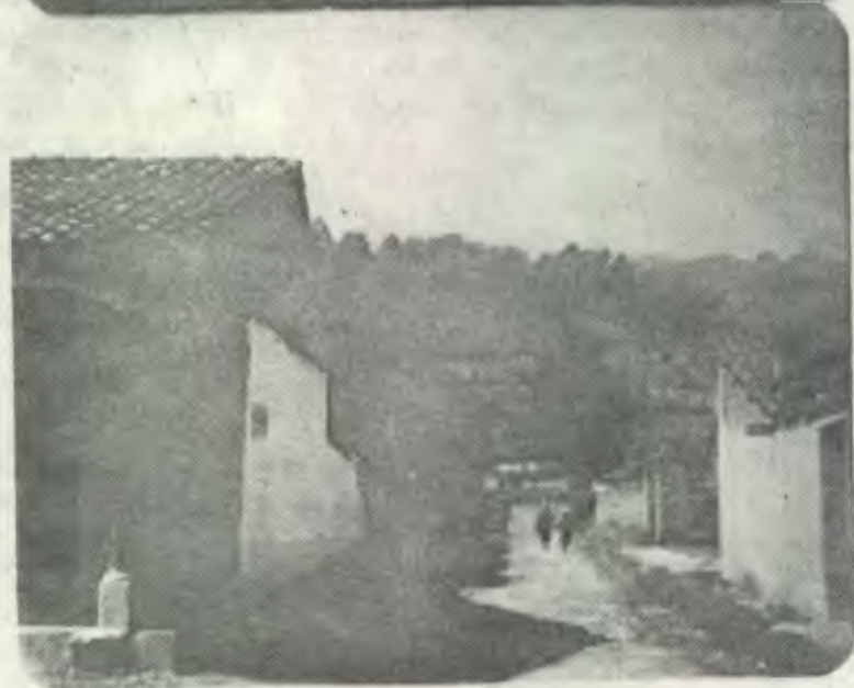
INFRAESTRUCTURA BASICA DEFICIENTE
