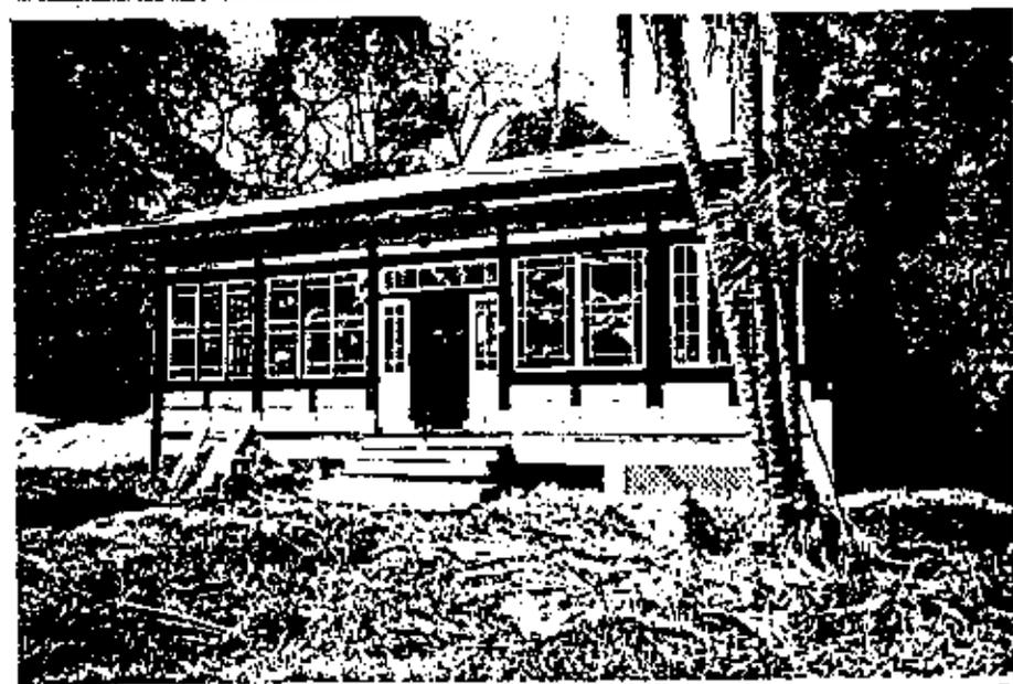
El sistema utilizado es el de estructura de madera con forro del mismo material, tanto para exteriores como interiores.
