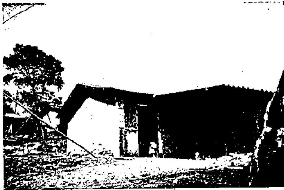
Se puede apreciar que a la fecha el sistema se sigue utilizando. En la presente lámina se tiene la edificación de una construcción de uso público en la que se utilizaron paneles de 1.22 mts. x 2.44 mts. para el cerramiento de áreas de muros, los que se han combinado de una manera adecuada con los materiales tradicionales como lo es el concreto, apreciándose además que el diseño del mismo es adecuado para nuestro medio.
